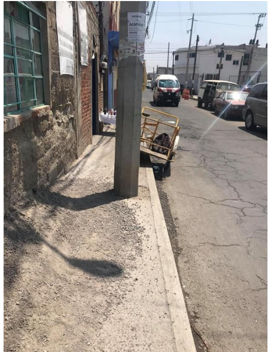
Foto 4; obstrucción peatonal. Fotografía propia.
