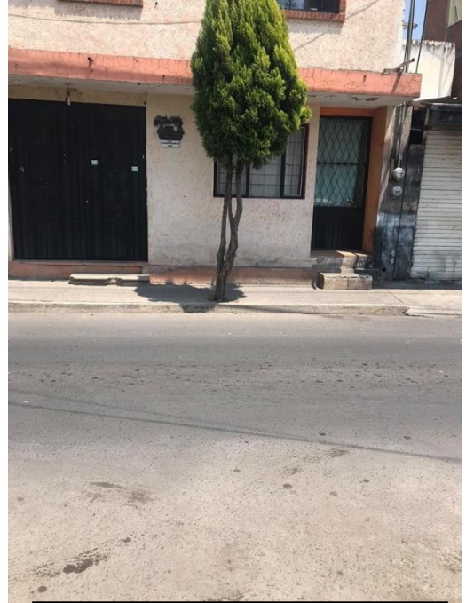
Foto 2; obstrucción peatonal. Fotografía propia.
