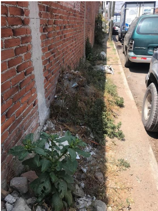
Foto 9; obstrucción peatonal. Fotografía propia.
