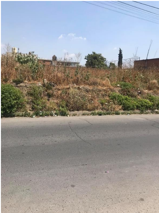
Foto 7; obstrucción peatonal. Fotografía propia.
