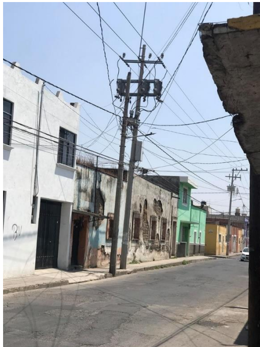
Foto 3; obstrucción peatonal. Fotografía propia.
