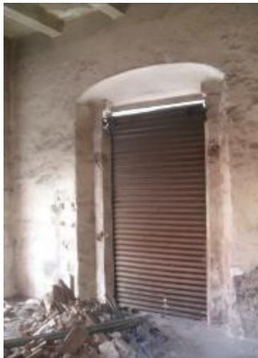
Ilustración 14 Núñez Gina, Sánchez Jacqueline. 2013. Tercera etapa de construcción de la vivienda, no se conservó la altura que se tiene en la primera etapa de construcción. El uso de cortinas metálicas indica que fue colocada en los años 90’s.
