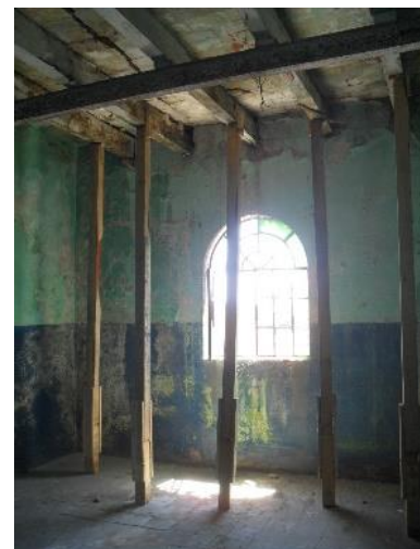
Ilustración 22 Núñez Gina, Sánchez Jacqueline. 2013. Detalle del apuntalamiento de losas en Planta Alta.
