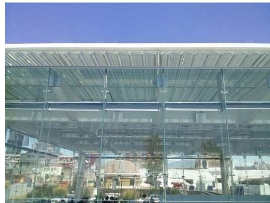
Ilustración 17. Núñez G. 2014. Cubierta ligera que protege la estructura acristalada de una incidencia solar directa.
