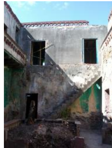
Ilustración 7 Muros del patio interior de la casona. Se observa la escalera que es considerada de la segunda etapa, originalmente el segundo nivel no existía en principio en la construcción. Núñez Gina, Sánchez Jacqueline. 2013.
