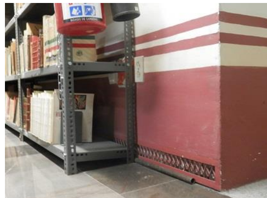
Ilustración 3. Núñez G. 2014. Colocación de drenes en la parte inferior del muro que presentaba humedad en el archivo de la B. Lafragua.
