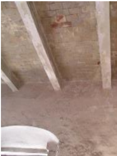
Ilustración 13 Núñez Gina, Sánchez Jacqueline. 2013. Tercera etapa de construcción de la vivienda, en la losa se utilizó concreto y acero para la colocación de las vigas que soportan la losa.
