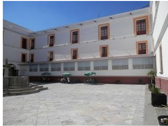
Ilustración 7. Núñez G. 2014. Ubicación temporal de la Biblioteca José Revueltas. Tercer patio del edificio Carolino.
