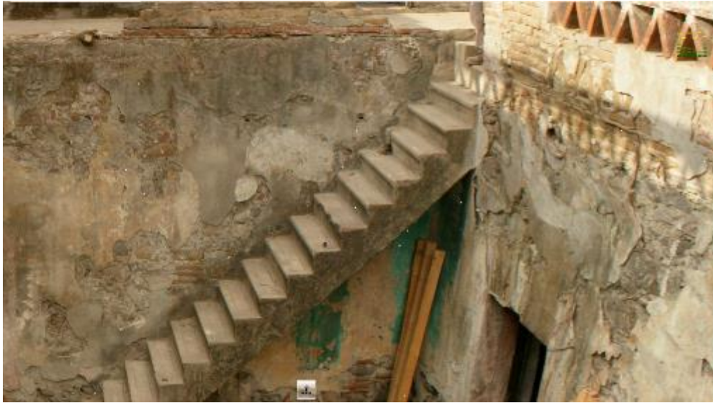
Ilustración 4. Núñez Gina, Sánchez Jacqueline. 2013. Muros del patio interior de la casona. Se observan muro de limosna (1ra. Etapa), escalera de concreto a segundo nivel (2da. Etapa).
