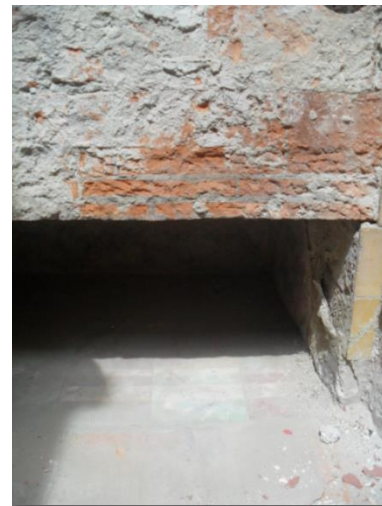
Ilustración 2 Núñez Gina, Sánchez Jacqueline. 2013. Losetas de barro, sin ningún motivo decorativo en piso, referente a la primera etapa de construcción de la vivienda.
