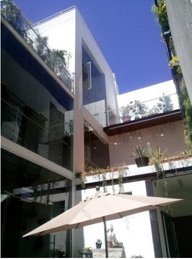
Ilustración 23. Núñez G. 2014. En la azotea se tiene un jardín que ayuda a que la incidencia solar no dé directamente sobre la azotea. Evitando una temperatura elevada al interior de las salas de exposición.
