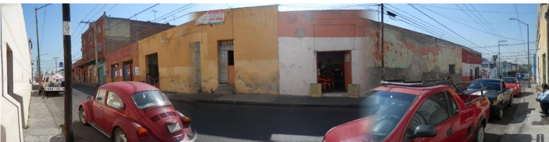
Ilustración 18. Sánchez J. Marzo 2014. Calle 14 sur Perfil de la manzana Sur al Inmueble de la Mapoteca, actualmente se encuentran 2 negocios de comida, así como un bar y una herrería, de igual forma casonas en mal estado que son utilizadas como vecindades.
