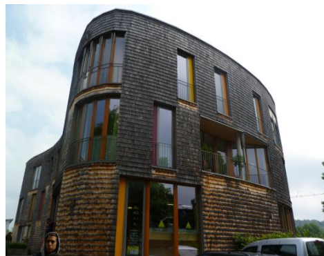
Imagen 1.11 Las tablas de madera en exteriores, típicas de esta región, y también son aislantes de ruidos.
