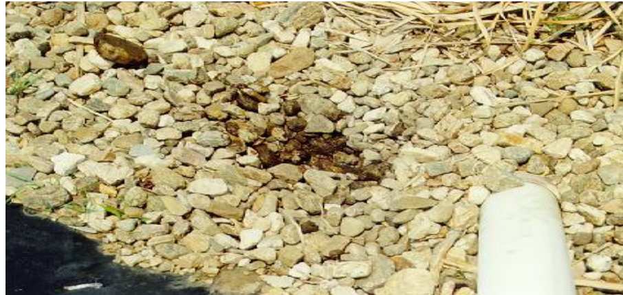
Figura 10. Medio de soporte de grava antes de la plantación (20).
