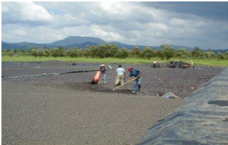
Figura 9. Colocación del medio granular (20).
