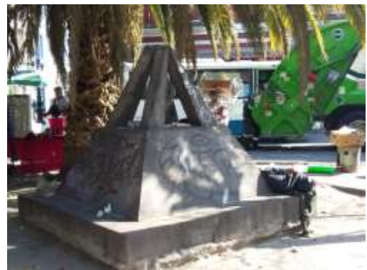
Imagen 94. Deterioro en base a monumento, Plazuela de San Luis. Foto: MEDA.
