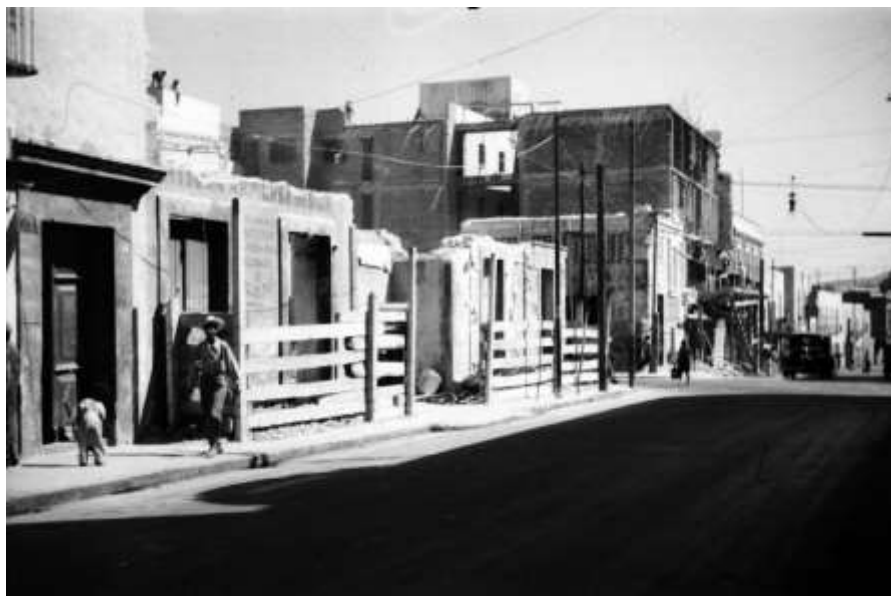
Imagen 65. Trabajos de demolición de la Armería del Deán, nombre que puede leerse en la fachada, casona que ocupaba la esquina de la Avenida 5 Oriente y 4 Sur, hoy Jardín del Arte. Fuente: página http://el-expediente-de-puebla.blogspot.com/2010/12/fotos-de-puebla-antigua_01.html
