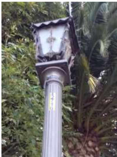
Imagen 99. Acumulación de suciedad en farol; Parque de la Pérgola. Foto: MEDA.
