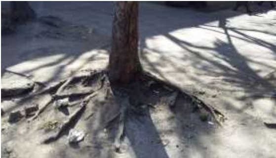
Imagen 90. Falta de mantenimiento en elementos vegetales; Plazuela de San Luis. Foto: MEDA.
