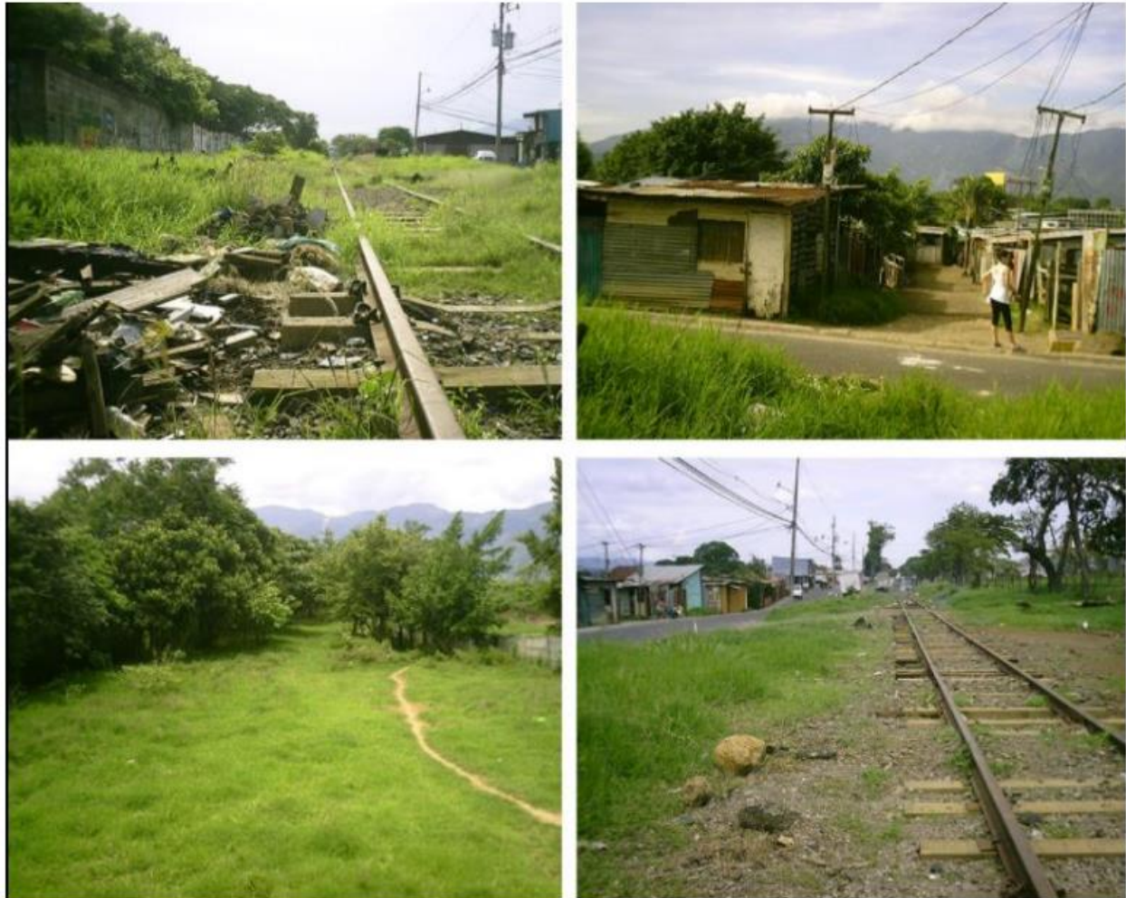
Figura 19 Vía férrea entre los barrios el futuro y calle arriba, antes del proyecto
