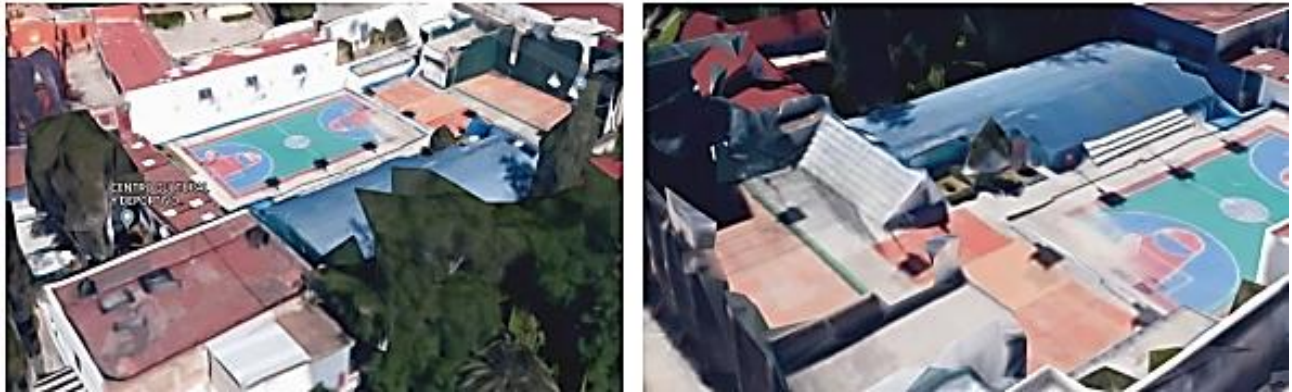
Figura 45 Vista aérea del centro cultural y deportivo
