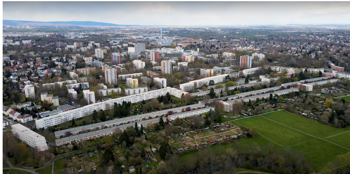
Figura 2, fotografía aérea del conjunto habitacional Siedlung Römerstadt, tomado de “Virtuelle Erkundung der Römerstadt als wichtiges Zeugnis des Neuen Frankfurt” [video] minuto 0:35, por architour, 2021, (184) Virtuelle Erkundung der Römerstadt als wichtiges Zeugnis des Neuen Frankfurt - YouTube
