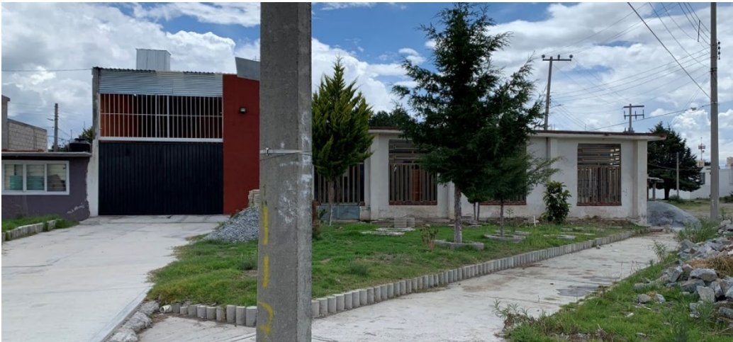
Figura 30, fotografía de fachadas de planta y primer nivel, colonia Villas de Sahagún.
