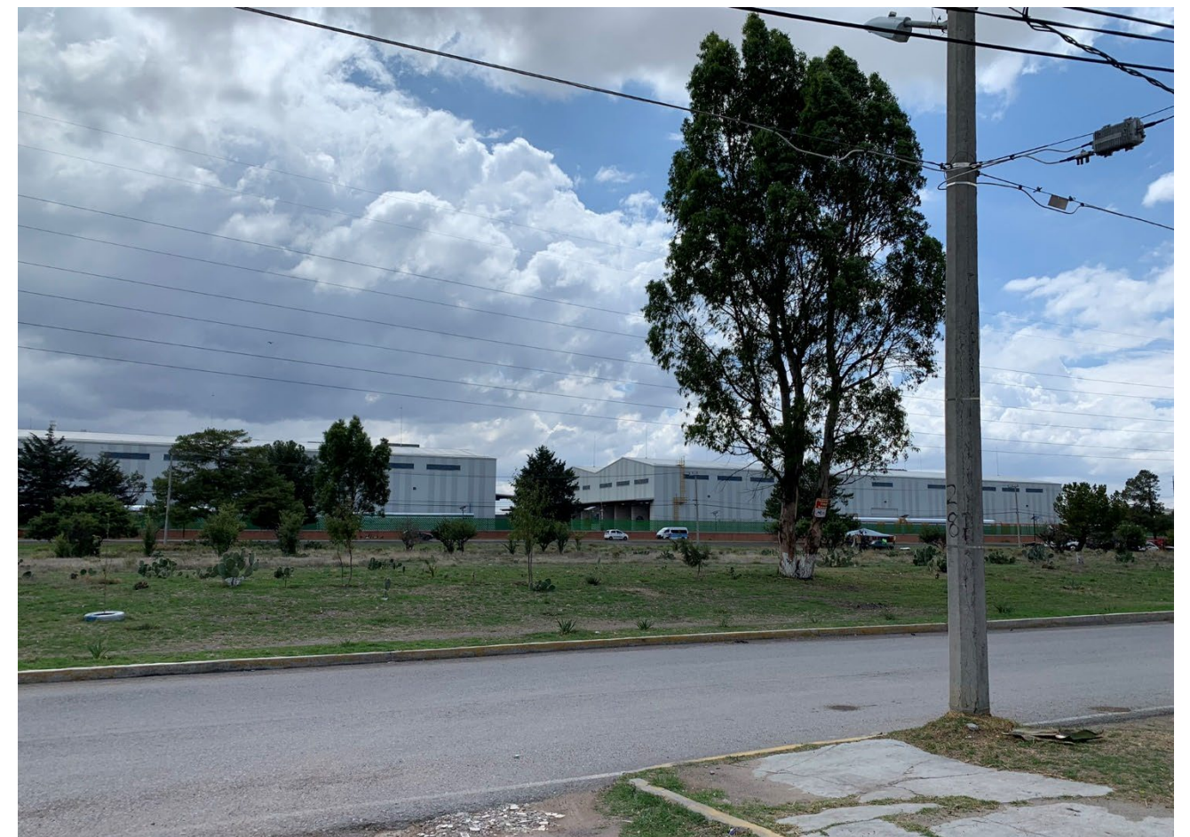
Figura 28 fotografía de naves industriales vista desde predio de proyecto.
