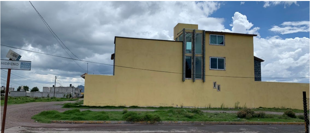
Figura 33, fotografía de fachada de dos niveles o "tres pisos" conocido así en la zona, colonia Villas de Sahagún.
