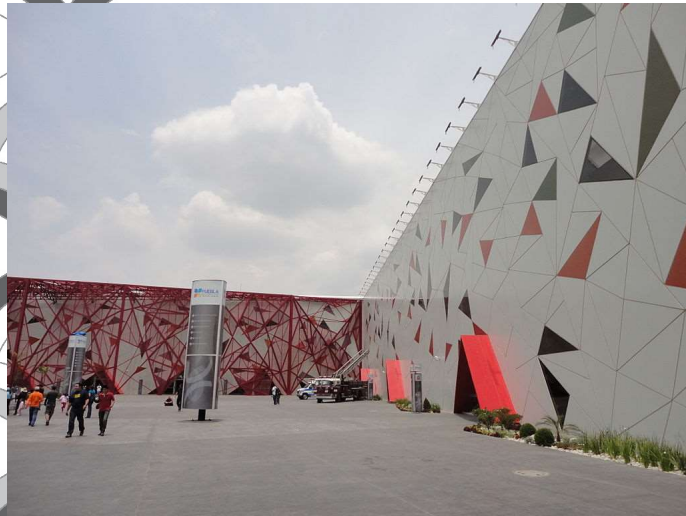
Fachada del centro de convenciones Puebla
