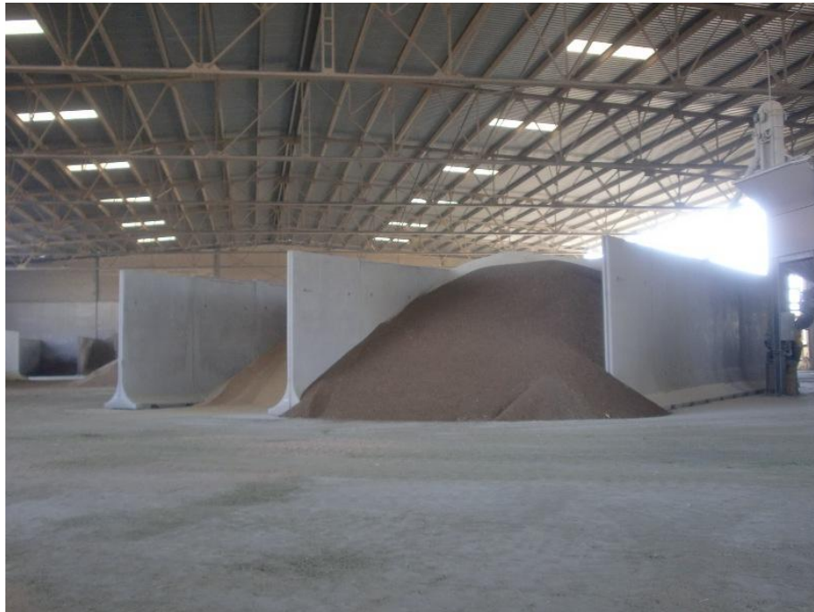
Bins para separar y almacenar producto a granel.
