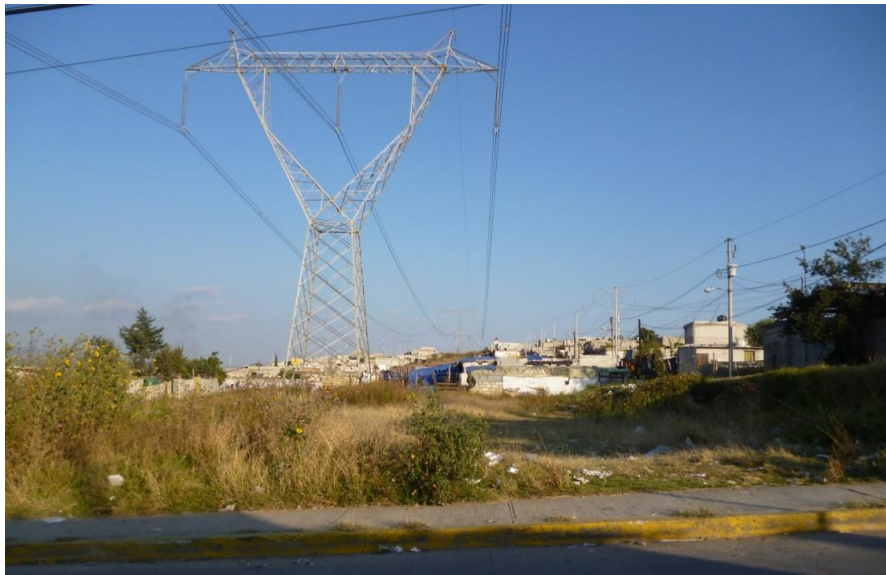
Ilustración 27.- Aspecto actual del derecho de vía de la línea de alta tensión de CFE y viviendas bajo las líneas.
