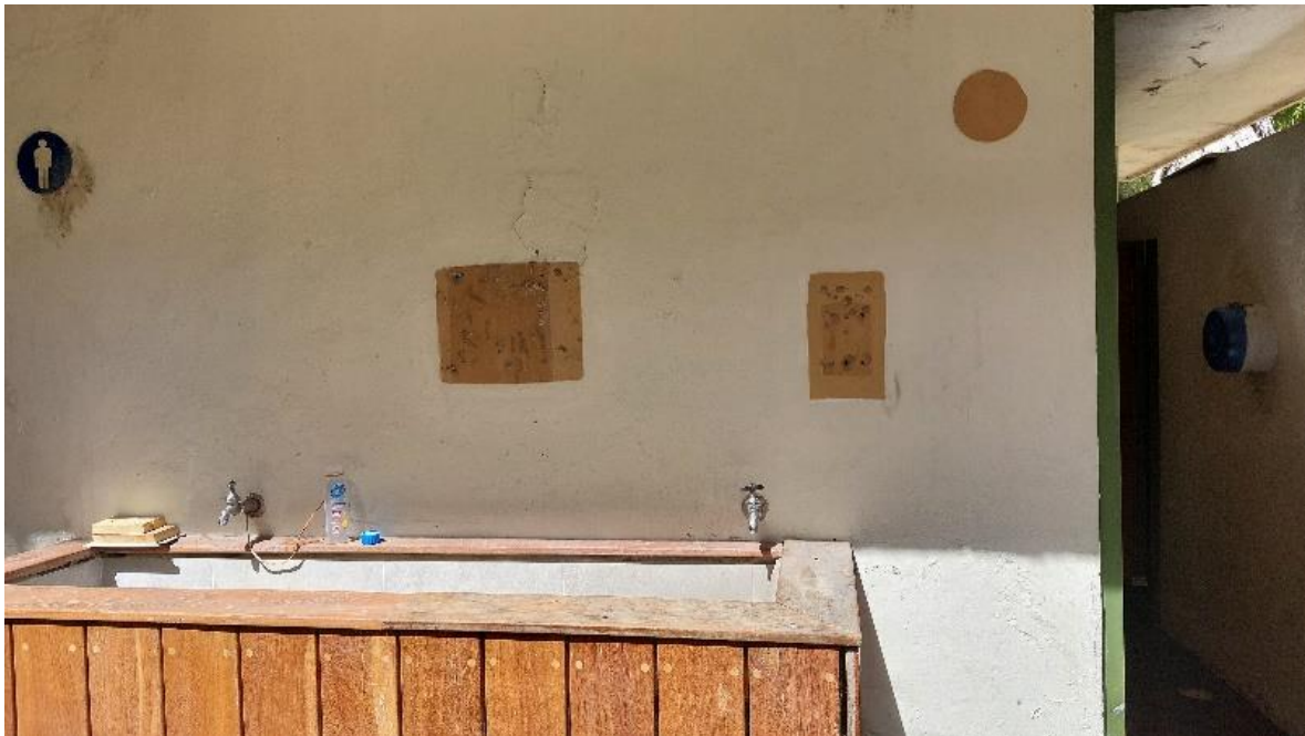
Imagen 70. Baños públicos, foto tomada durante visita de campo (febrero 2024)
