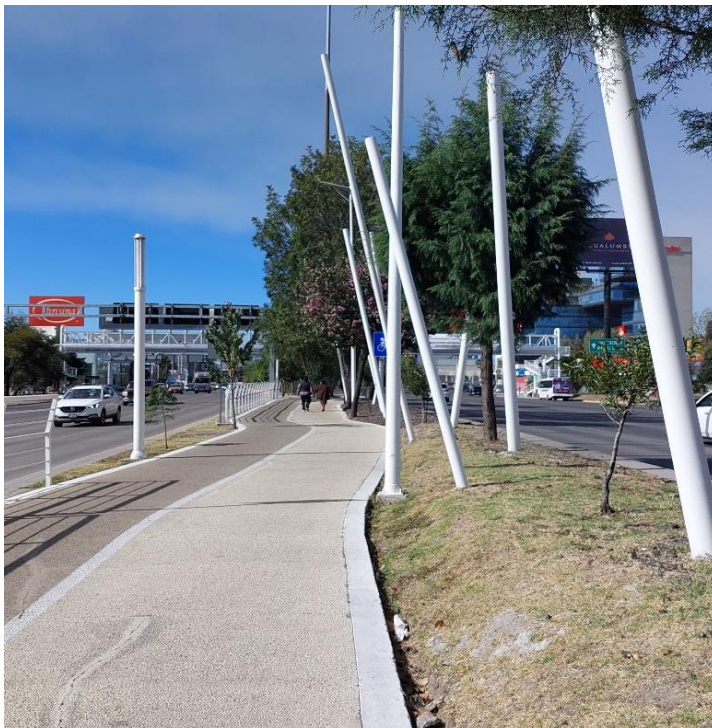
Imagen 28. Luminaria, foto tomada durante visita de campo (febrero 2024)
