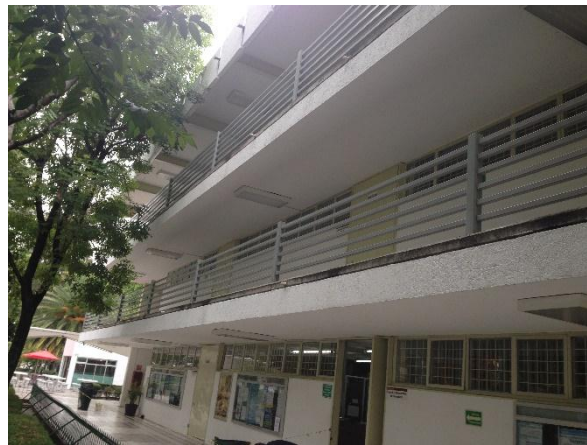
Figura 3.5 Edificio ING8 de la Facultad de Ingeniería.
