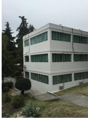
Figura 3.4 Edificio ING7 de la Facultad de Ingeniería.
