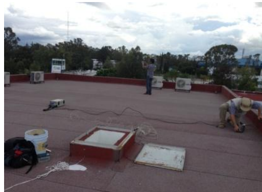
Figura 3.16 Medición de ruido ambiental en losa de azotea de edificio ING7
