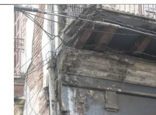
Acción de liberación y reposición de Redes Técnicas eléctricas de Palacio Pichardo
