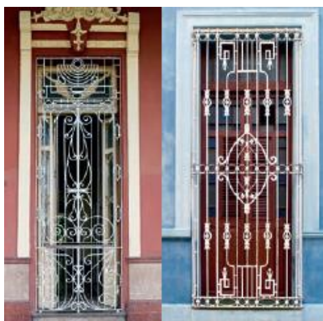
Herrería sobrepuesta en ventanas de Madera, Camagüey, República de Cuba Fuente: Guía de Arquitectura y Paisaje, Camagüey
