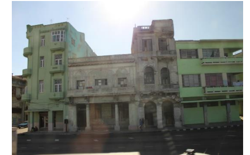
Edificio grado de Protección 4, Habana Vieja Foto: Aldair Fernández de Lara, Febrero 14, 2014
