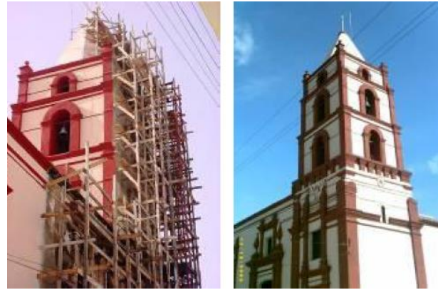
Rehabilitación del templo de la Soledad, centro Histórico Urbano de la Ciudad de Camagüey. Fuente: Acciones de Conservación en el Centro Histórico de Camagüey
