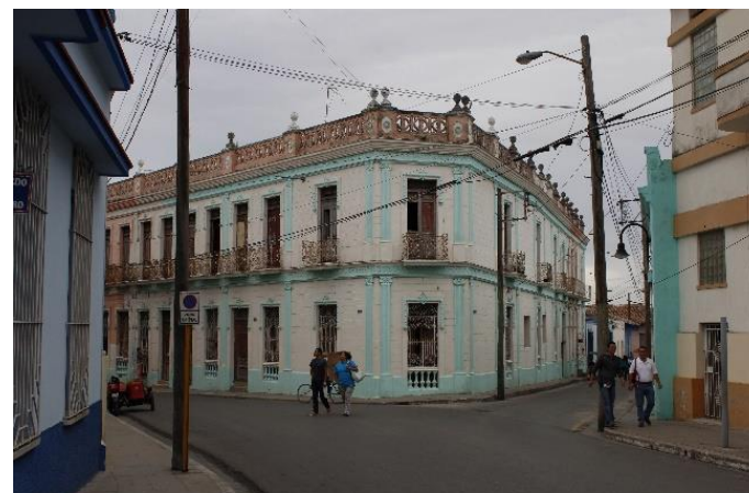
Ejemplo Arquitectónico de la tipología de la ciudad de Camagüey Foto: Fernández de Lara, Aldair, Ciudad de Camagüey, Febrero 2015
