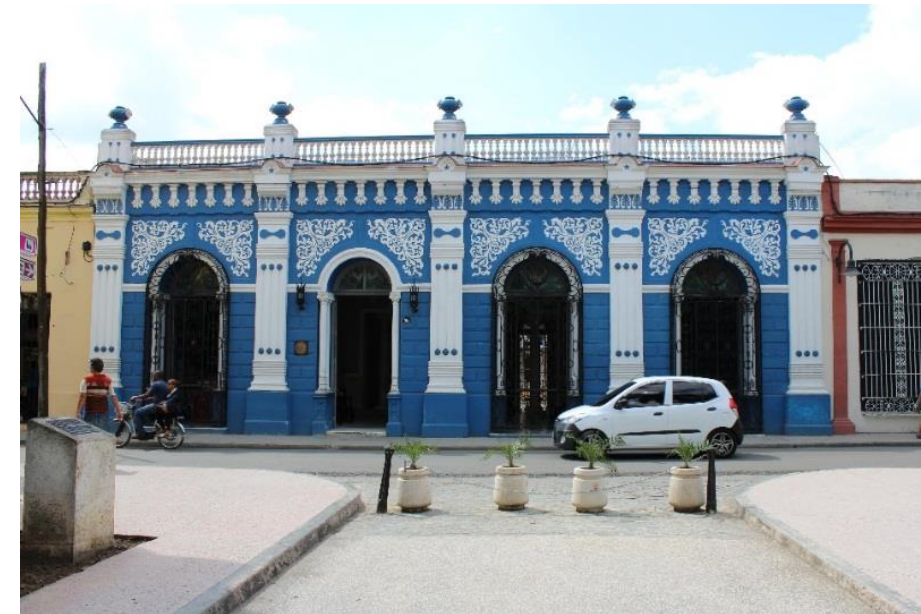
Detalles de pilastras en el edificio de la Oficina del historiador de la arquitectura en Camagüey, República de Cuba Fuente: Guía de Arquitectura y Paisaje, Camagüey
