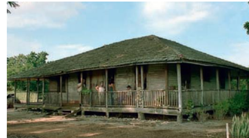
Detalle de una casa de madera en un centro azucarero, Camagüey, República de Cuba Fuente: Guía de Arquitectura y Paisaje, Camagüey
