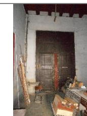
Baños construidos en el patioZaguan del Palacio Pichardo Foto: Aldair Fernández de Lara, Febrero 14, 2014
