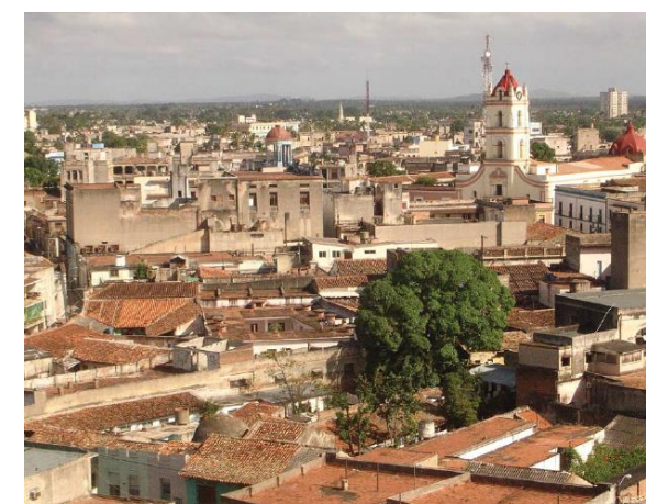
Vista de la ciudad de Camagüey en el período de Consolidación, con un crecimiento en aspectos de trazo urbano y social. Fuente: Guía de Arquitectura y Paisaje, Camagüey
