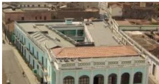
Vista Aérea de una construcción Camagüeyan. Se observa el patio central, los vanos, los portales, techos inclinados para el almacenamiento de agua. Fuente: Acciones de Conservación en el Centro Histórico de Camagüey
