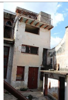
Baños construidos en el patio Foto: Aldair Fernández de Lara, Febrero 14, 2014
