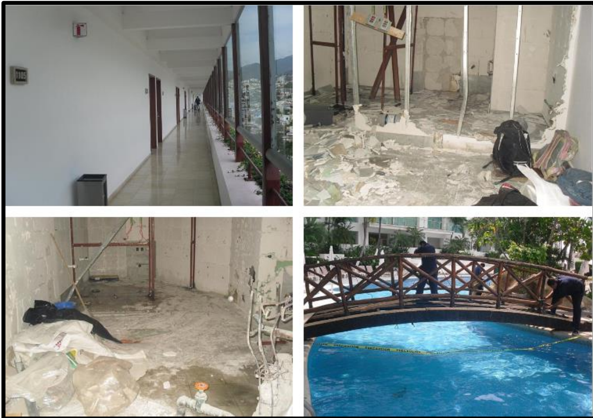
Ilustración 4.7 remodelación y mantenimiento de las áreas del hotel
