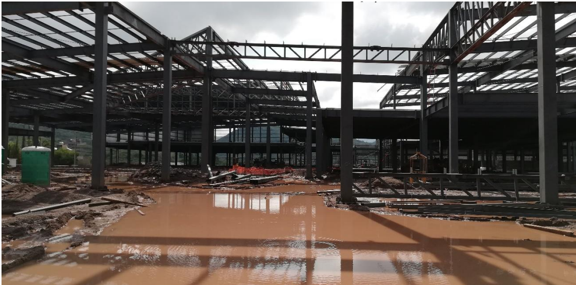
Fig. 43, Monitoreo de estructuras metálicas
