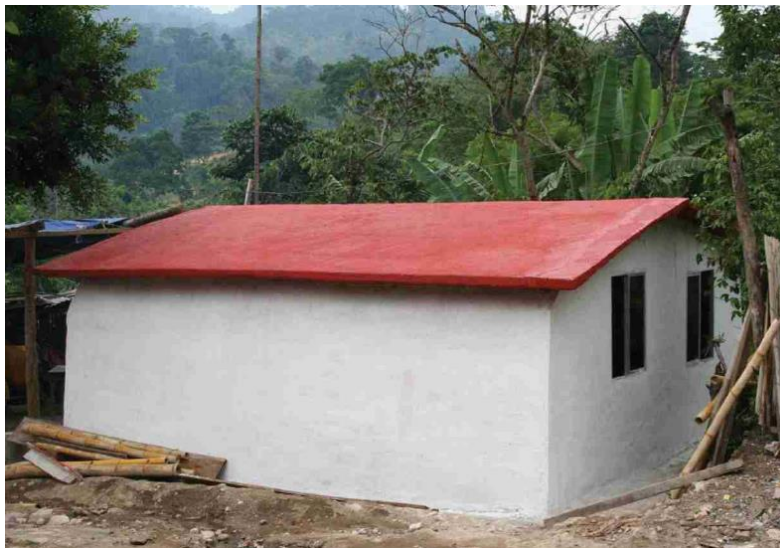
Imagen 4-1 Casa tipo elaborada con moldes prefabricados para zona rural
