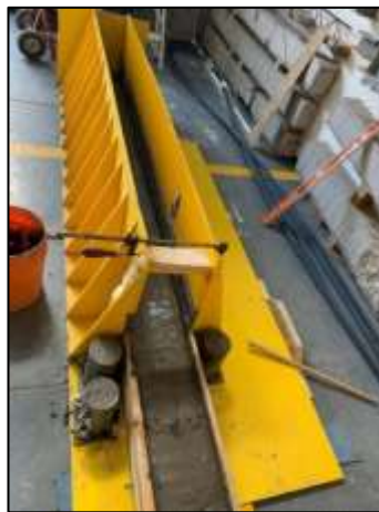
Figura 3.10 Colado del muerto
