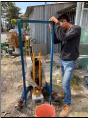
Figura 16 Empotramiento de columnas.
