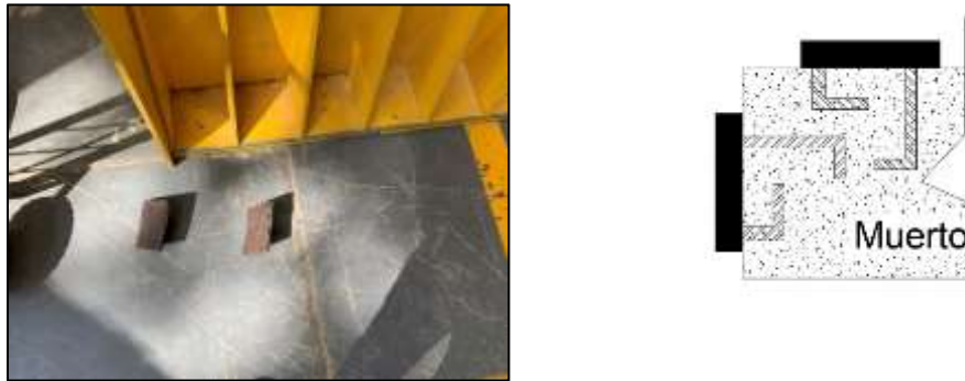
Figura 3.9 Placa de acero empleados en el muerto
