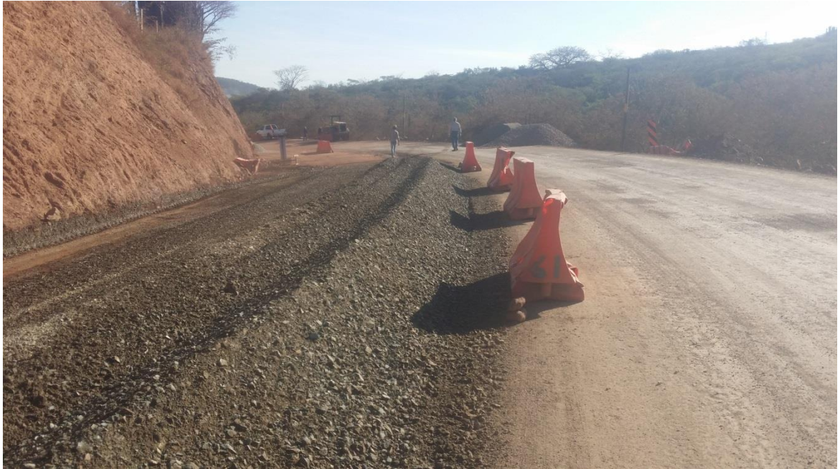
Fig. IV.5.4.1. 3 CONSTRUCCIÓN DE LA BASE HIDRAULICA Fuente: Elaboración propia
