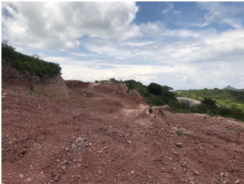
Fig. IV.5.2.3.3 TRABAJOS DE CORTE Y EXCAVACIONES DEL KM. 81+000 AL 81+920 Fuente: Elaboración propia
