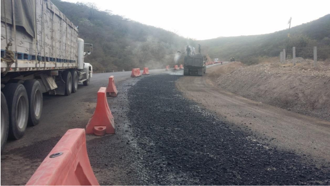
Fig. IV.5.4.2.4 TENDIDO DE LA BASE ASFÁLTICA
