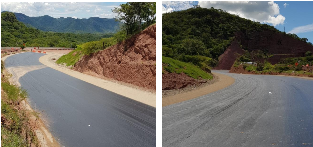
Fig. IV.5.4.2.1 IMPREGNACIÓN DE LA BASE HIDRÁULICA Fuente: Elaboración propia
