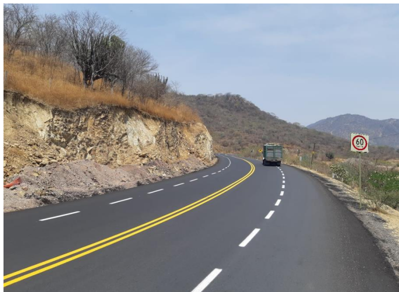
Fig. IV.5.4.4.1 Señalamiento horizontal y vertical del tramo Fuente: Elaboración propia
