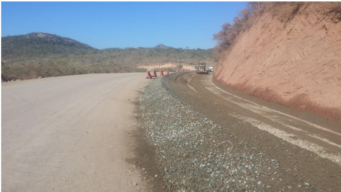
Fig. IV.5.4.1 .2 CONSTRUCCIÓN DE LA BASE HIDRAULICA Fuente: Elaboración propia
