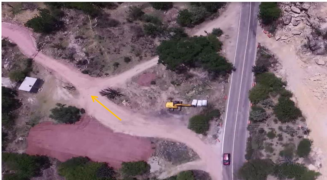
Fig. IV.5.1.2 BANCO DE TIRO KM. 84+680
