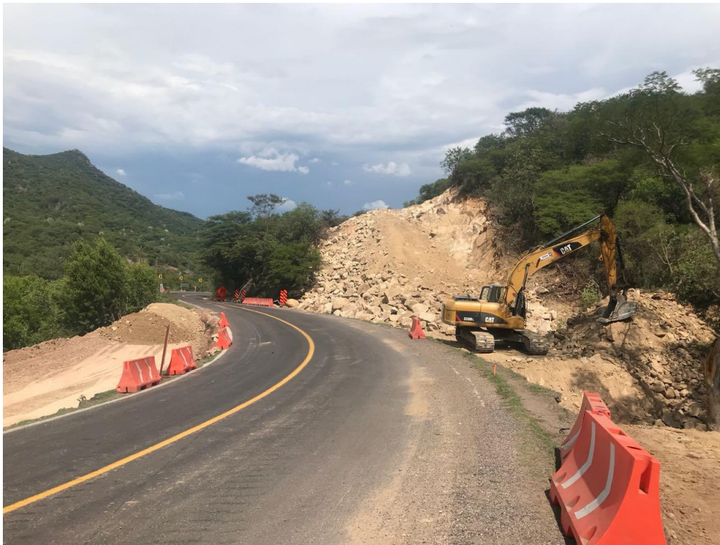
Fig. IV.5.2.3.11 AMPLIACION DE CALZADA DEL KM. 82+620 AL 83+820 Fuente: Elaboración propia
