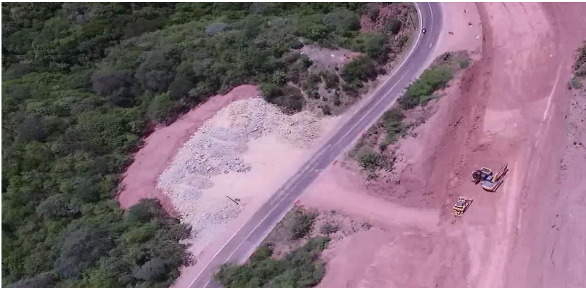
Fig. IV.5.2.3.14 BANCO DE TIRO KM. 83+000 Fuente: Elaboración propia
