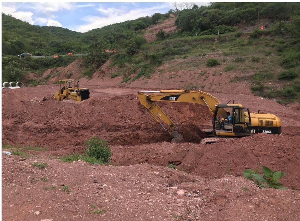
Fig. IV.5.2.3.7 TRABAJOS REALIZADOS DEL KM. 81+920 AL 82+620 Fuente: Elaboración propia
