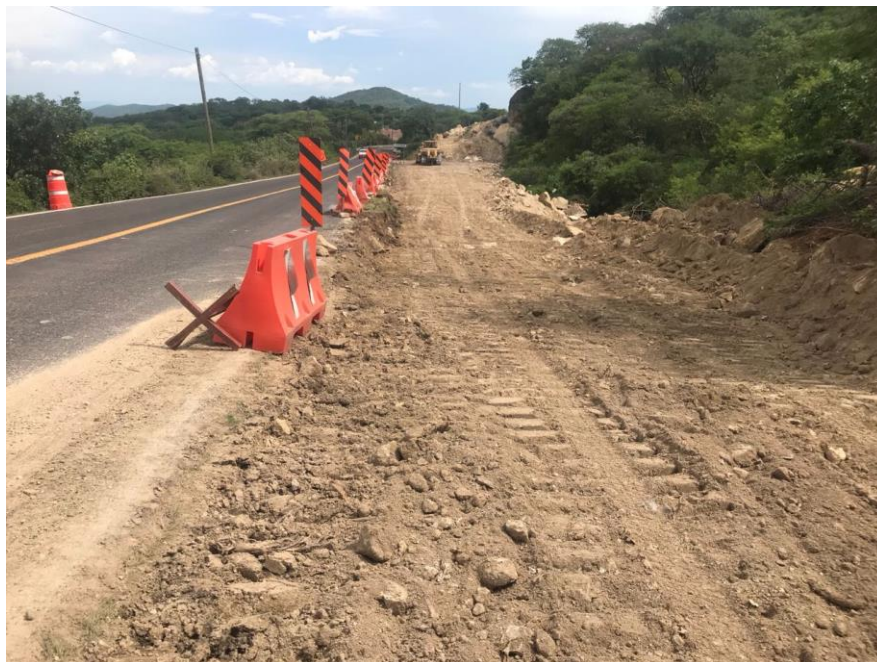
Fig. IV.5.2.3.15 DESARROLLO DE LOS TRABAJOS DEL KM. 83+820 AL 85+000 Fuente: Elaboración propia
