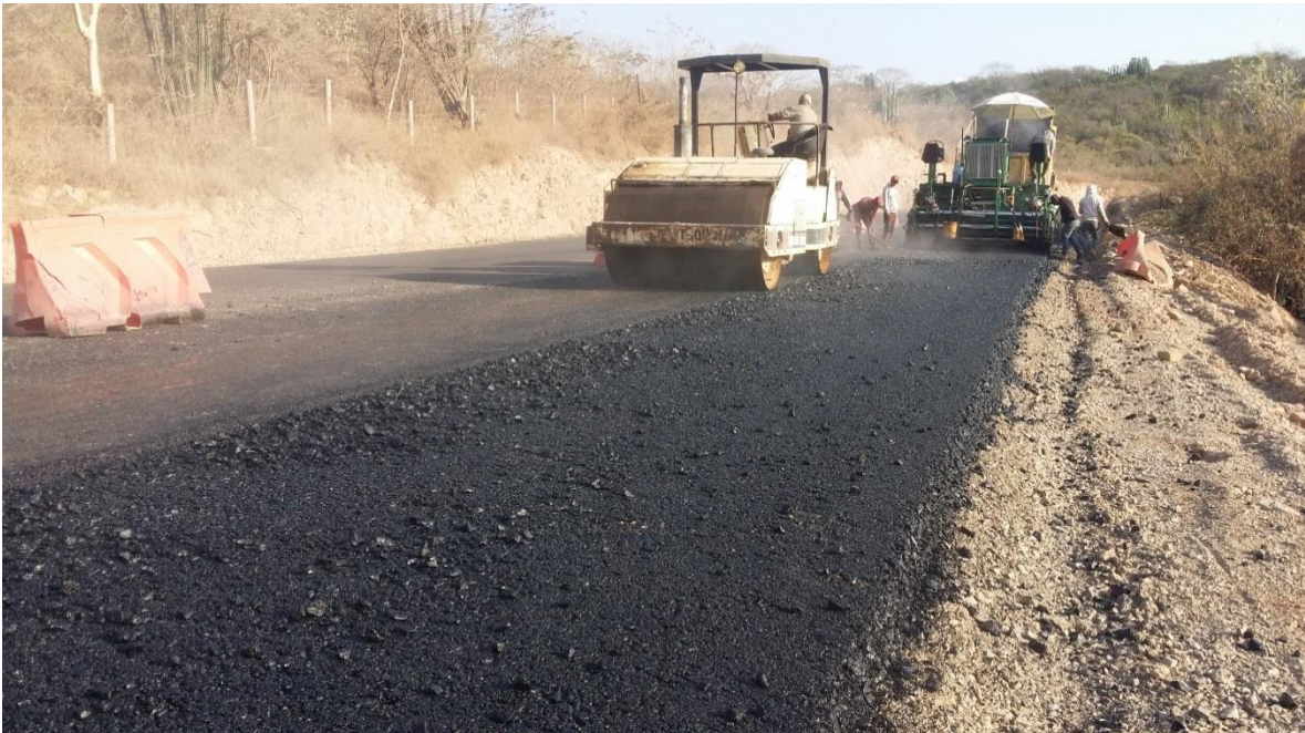
Fig. IV.5.4.3.2 COMPACTACION DE CARPETA ASFÁLTICA Fuente: Elaboración propia
