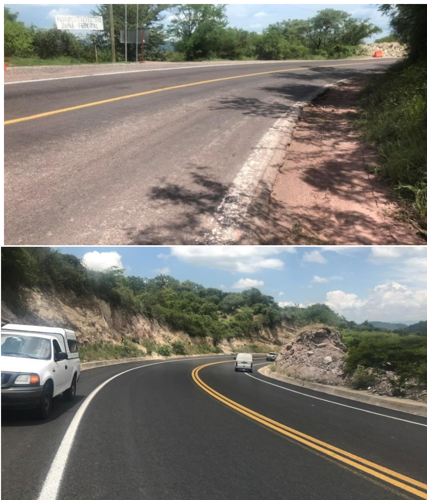
Fig. II.2.2 MODERNIZACION DE LA CARRETERA IZUCAR DE MATAMOROS – ACATLAN DE OSORIO. DE TIPO “C” A TIPO “A2” FUENTE: Elaboración propia
