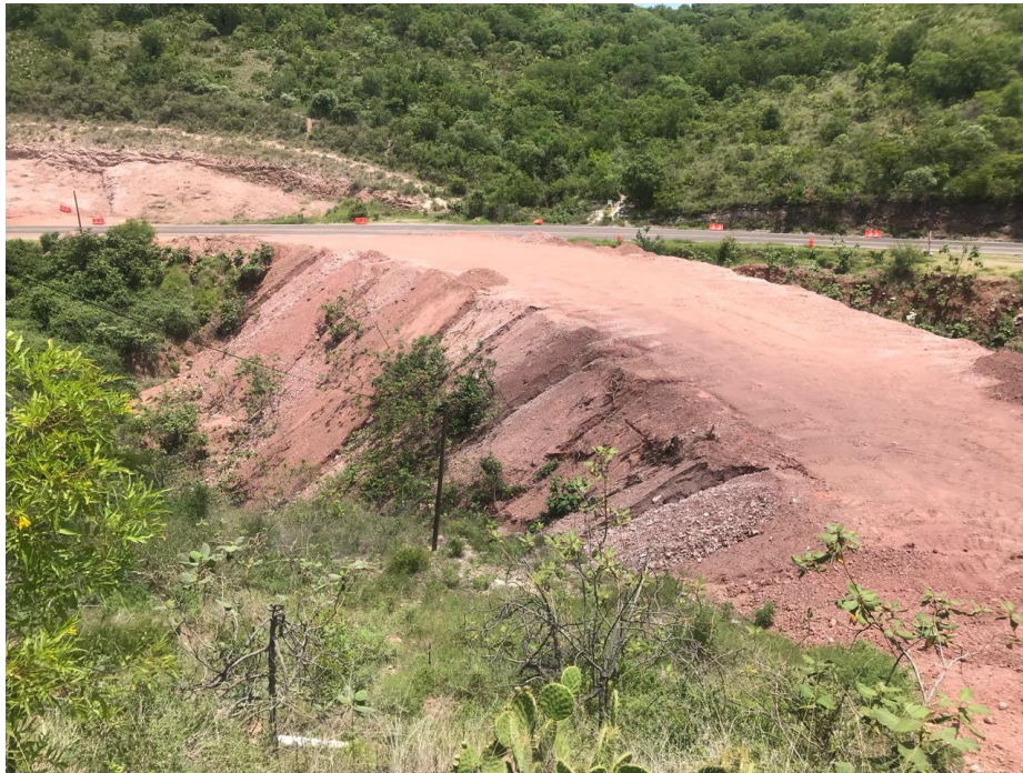
Fig. IV.5.2.3.4 CONFORMACIÓN DE TERRAPLÉN DEL KM. 81+000 AL 81+920 Fuente: Elaboración propia
