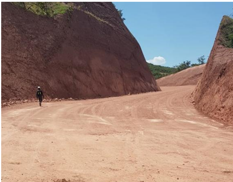
Fig. IV.5.2.2.2 CONSTRUCCIÓN DE LA CAPA SUBRASANTE Fuente: Elaboración propia
