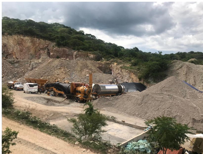
Fig. IV.5.4.3.1 PRODUCCION DE CARPETA ASFALTICA EN BANCO “TEPENENE” Fuente: Elaboración propia
