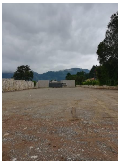
Figura 10. Inicio de construcción de fraccionamiento
