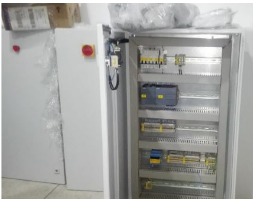
Figura 5.17: Esqueleto común para los tableros
