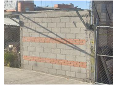
f) Aparejo con tres hiladas de tabique a cada tercio del muro.
