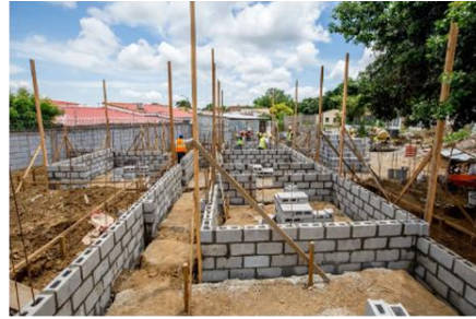
b) Construcción de casa habitación
