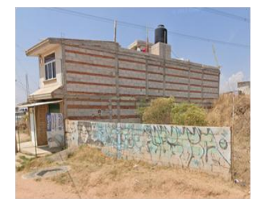
k) Aparejo dos hiladas de tabique por dos de block
