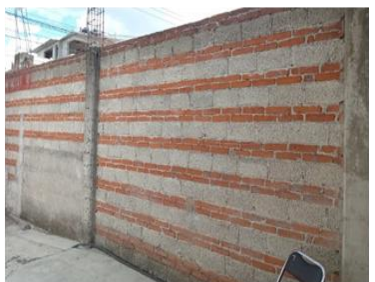
d) Aparejo una hilada de block por dos hiladas de tabique
