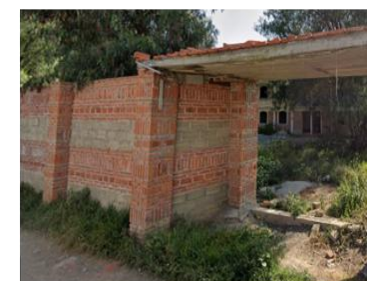
i) Aparejo de tres hiladas de block colocadas al hilo e hiladas de tabique colocadas de diferentes posiciones.
