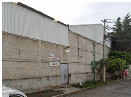
a) Nave con muros de mampostería
