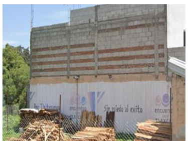
g) Aparejo tres hiladas de tabique por una de block donde cambia el aparejo a hiladas de block.
