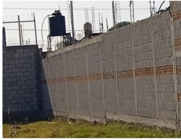
e) Aparejo con tres hiladas de tabique en el centro y diez de block.
