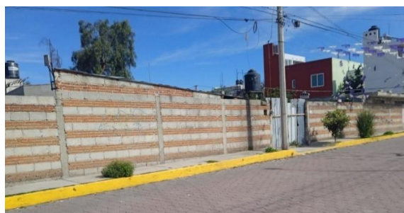
Figura 8 Uso de mampostería combinada (Autoría propia, 2024)
