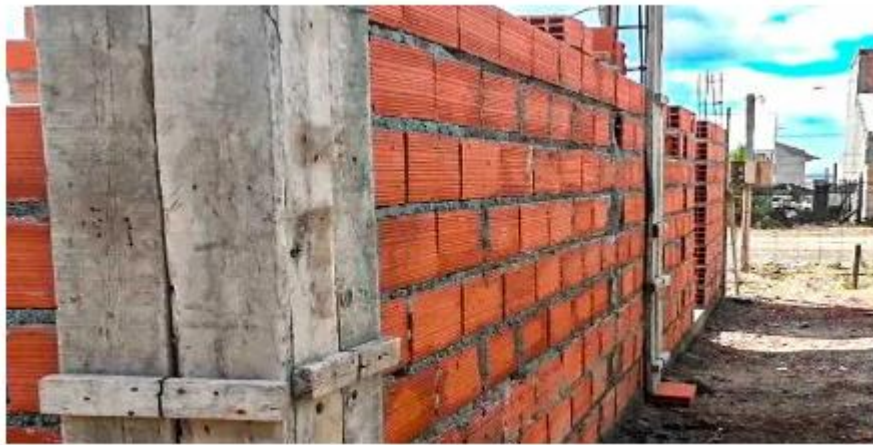
Figura 3 Construcción de muro de mampostería (Fuente: Pagina web_Grupo Casalina, 2022)
