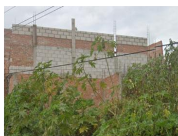
h) Aparejo hilas de block con hiladas de tabique para despues continuar con block.
