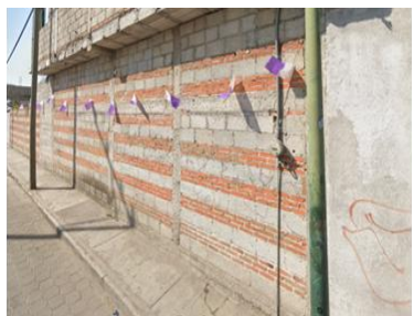
a) Aparejo una hilada de block por tres hiladas de tabique
