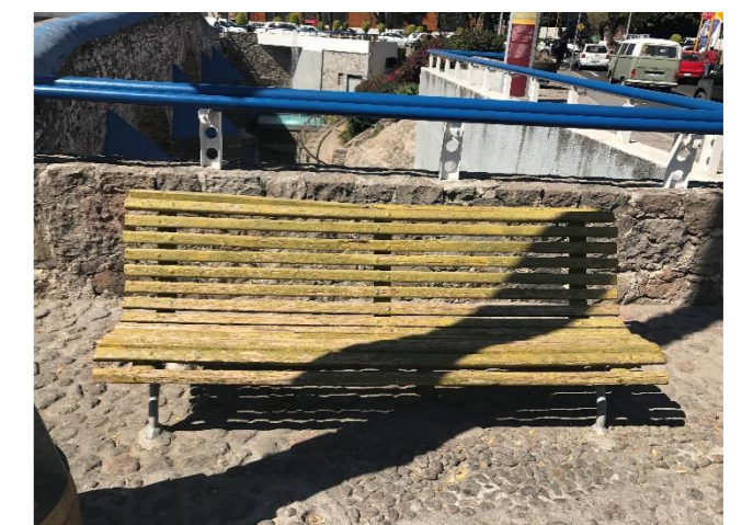
Imagen 2.14 Banca de madera en mal estado. Ubicada alrededor del Puente de Ovando. Karime León 2017.
