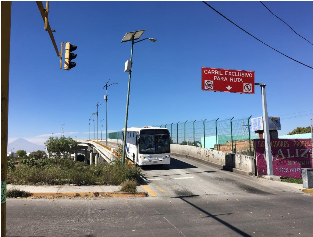
Imagen 5. Carriles Confinados del Sistema RUTA - Línea 1 (Fuente propia).
