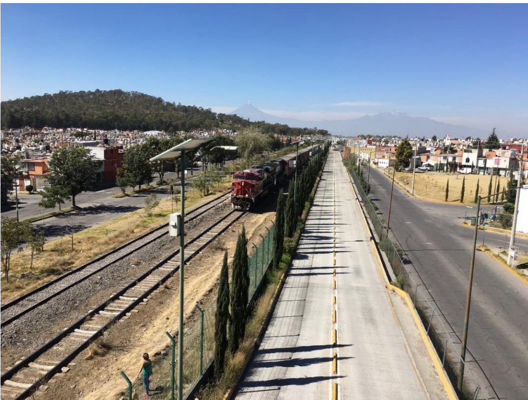
Imagen 4. Carriles Confinados del Sistema RUTA - Línea 1 (Fuente propia).
