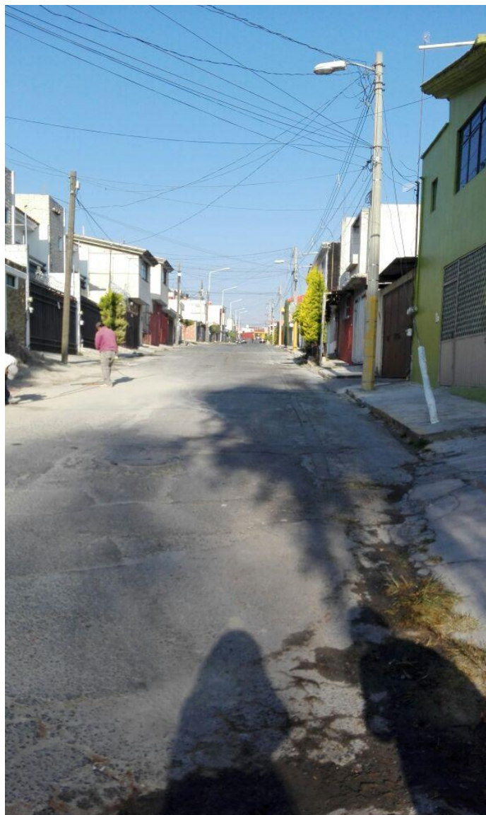
Ilustración. Banquetas con desniveles. Alejandra. A. M. Enero 2017
