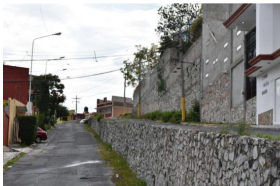
Ilustración. Pendiente pronunciada en calle principal Aguilar A. Noviembre 2017
