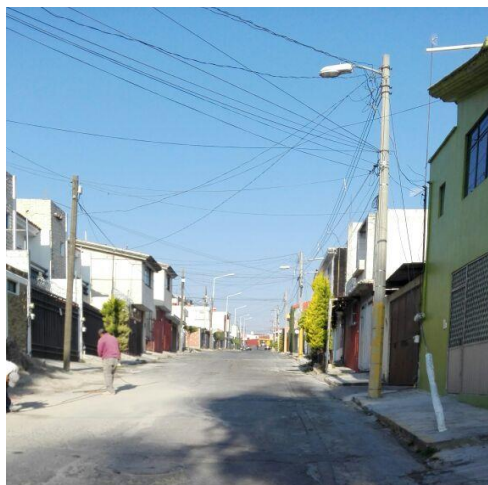
Ilustración. Banquetas con desniveles. Alejandra. A. M. Enero 2017
