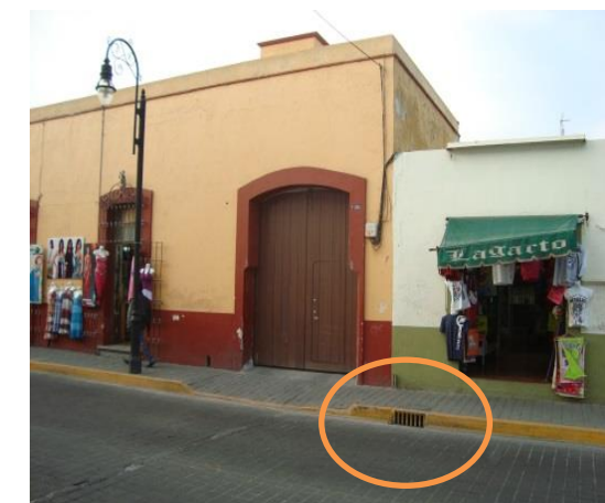
Imagen 27 Coladera pluvial de banqueta con rejilla. (Fuente: fotografía propia de los autores).
