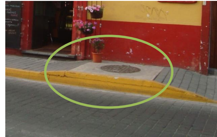
Imagen 29 Registro de red de electricidad. (Fuente: fotografía, propia de los autores).
