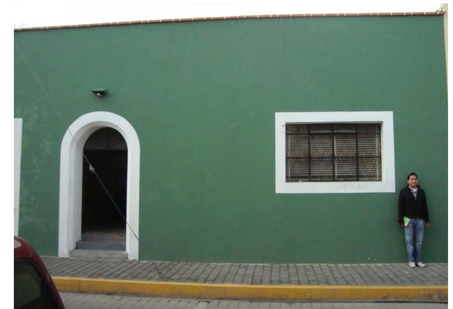
Imagen 7 Abajo derecha: Fotografía actual de la fachada de una vivienda, después de la rehabilitación hecha para el nombramiento de Cholula como Pueblo Mágico. (Fuente: Fotografía propia de los autores, Febrero 2014)
