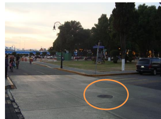
Imagen 26 Pozo de visita (Brocal con tapa) (Fuente: fotografía propia de los autores).
