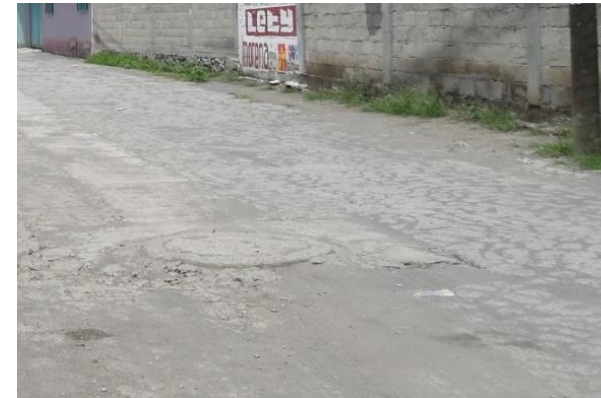
Imagen 89: Servicio de drenaje en Terreno destinado a proyecto. Fotografía tomada por Rosa María Luna Rosas, julio 2021
