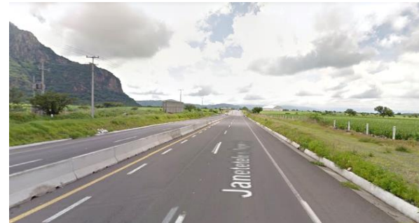
Imagen 50: Carretera Federal Tepexco México No. (Fuente Google Maps).
