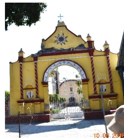
Imagen 5: Parroquia de Tlapanalá. Fuente: Maestría en Conservación del Patrimonio Edificado, BUAP
