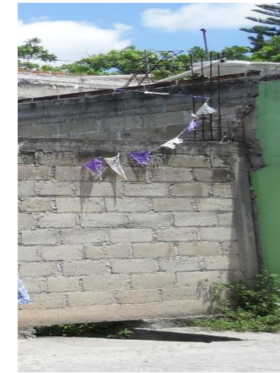
Imagen 68: Acequia que cruza las viviendas y terrenos tomada el 8 de septiembre de 2018, tomada por equipo.
