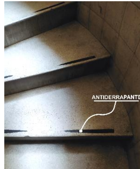
Imagen 124: Escalera de edificio. Fotografía tomada por Rosa María Luna mayo de 2021.
