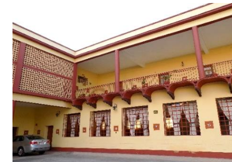
Imagen 119: Ventanas en Instituto Salesiano Ponce de León. Fotografía tomada por: Katia Posadas marzo de 2019.
