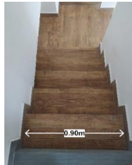
Imagen 122: Ancho de escalera en Casa de Oración La Nueva Esperanza. Fotografía tomada por: Rosa María Luna agosto de 2021.
