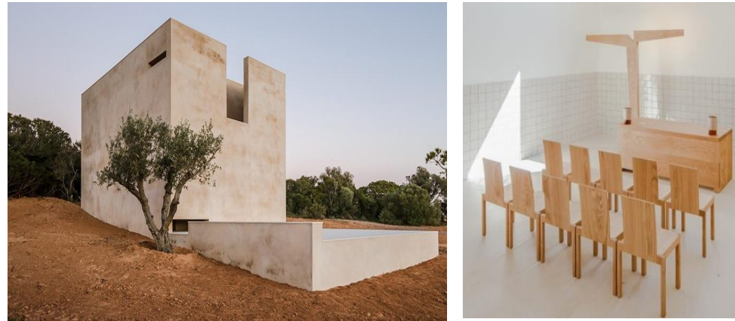
Imagen 13: Centro en Monte da Charneca, se muestra vista exterior e interior del recinto, fotografías tomadas por João Morgado, recuperado de: https://www.disup.com/alvaro-siza-vieira-capela-do-monte-capilla-del-monte-da-charneca-portugal/
