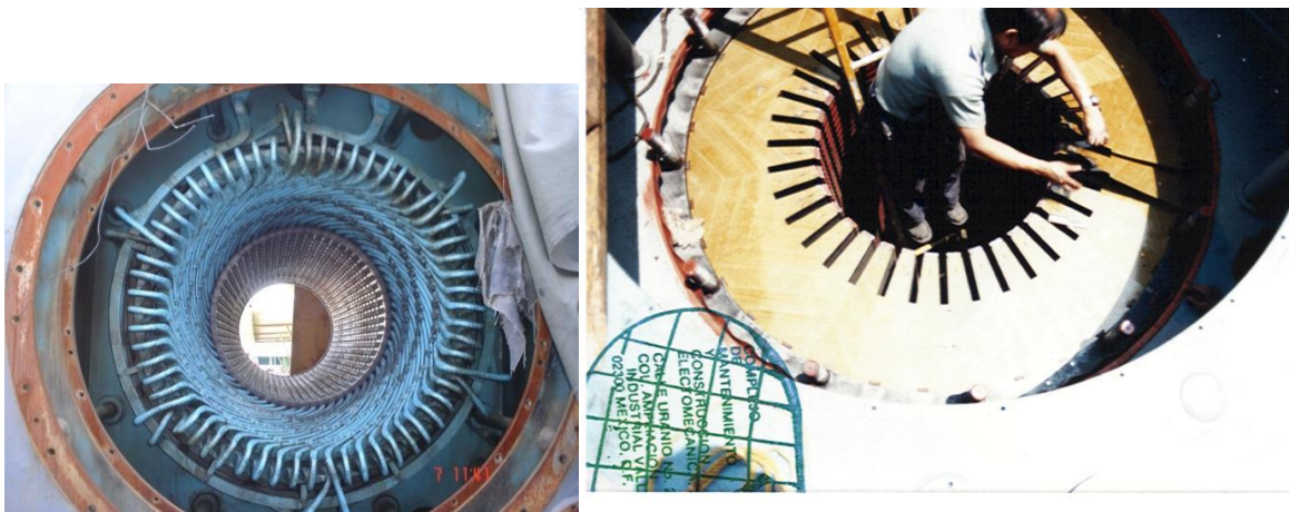
Figura 3.4. Estator y sistema de enfriamiento, relaminación de devanado de estator.
