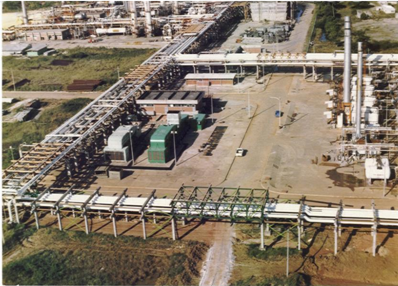
Figura 3.2 Central de generación en complejo industrial Pemex..
