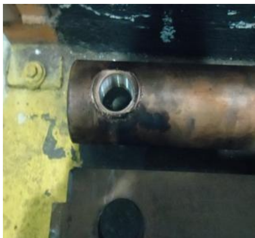
Figura 3.23.- Barra de conexión del interior de la flecha y punto de falla.
