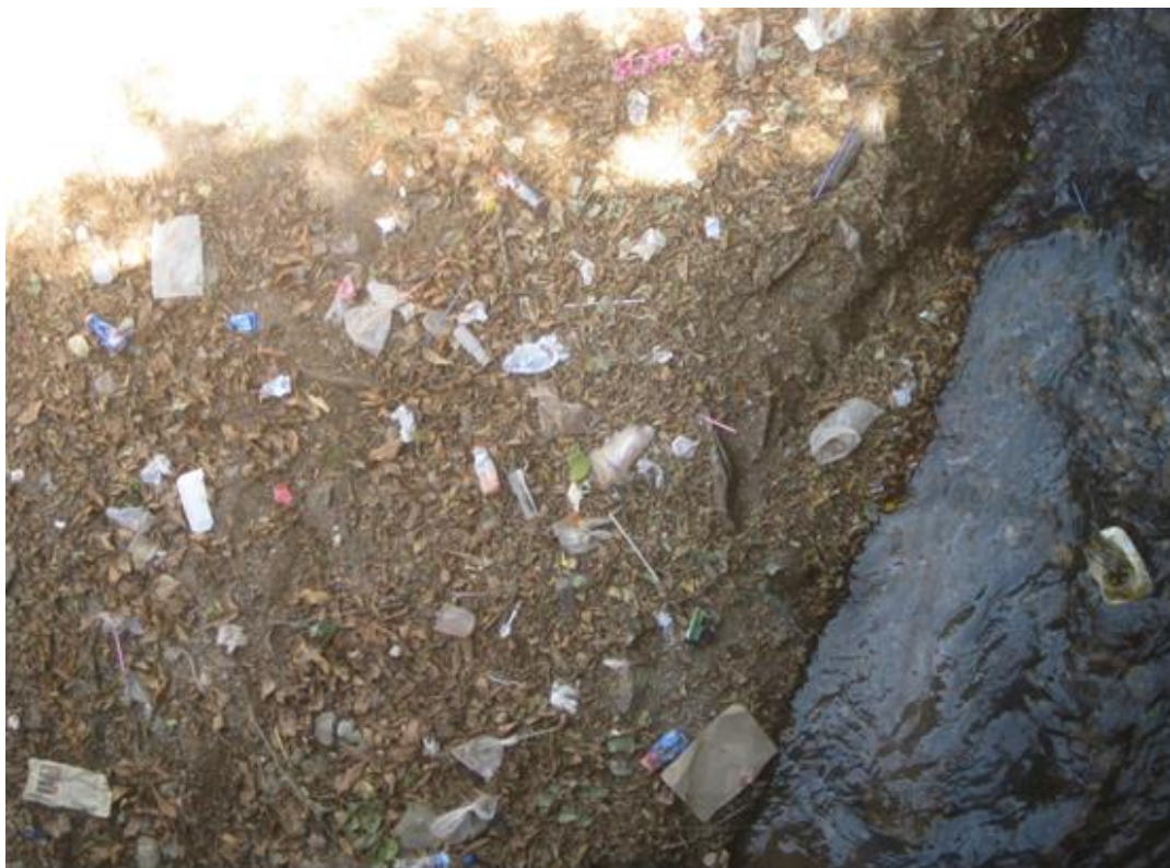
Imagen 58. Contaminación por aguas residuales Fotos: Fuente del autor, 2013
