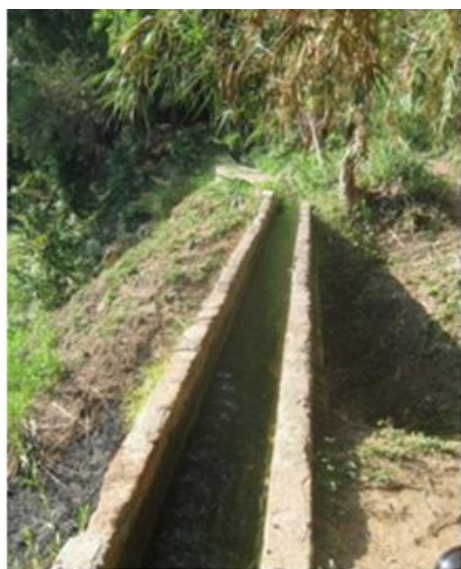
Imagen 27. Canal que conduce el agua del río a la zona de riego.
