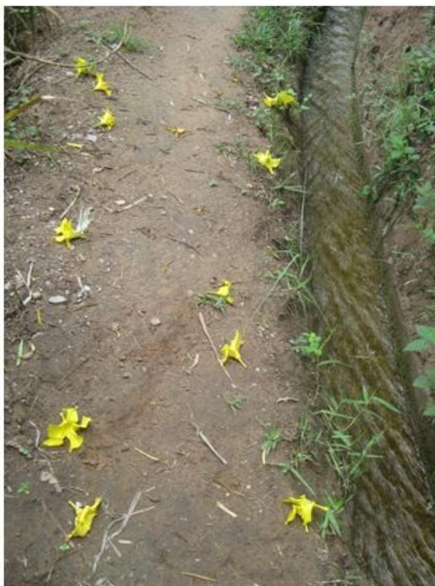
Imagen 4. Canal que conduce el agua de riego.
