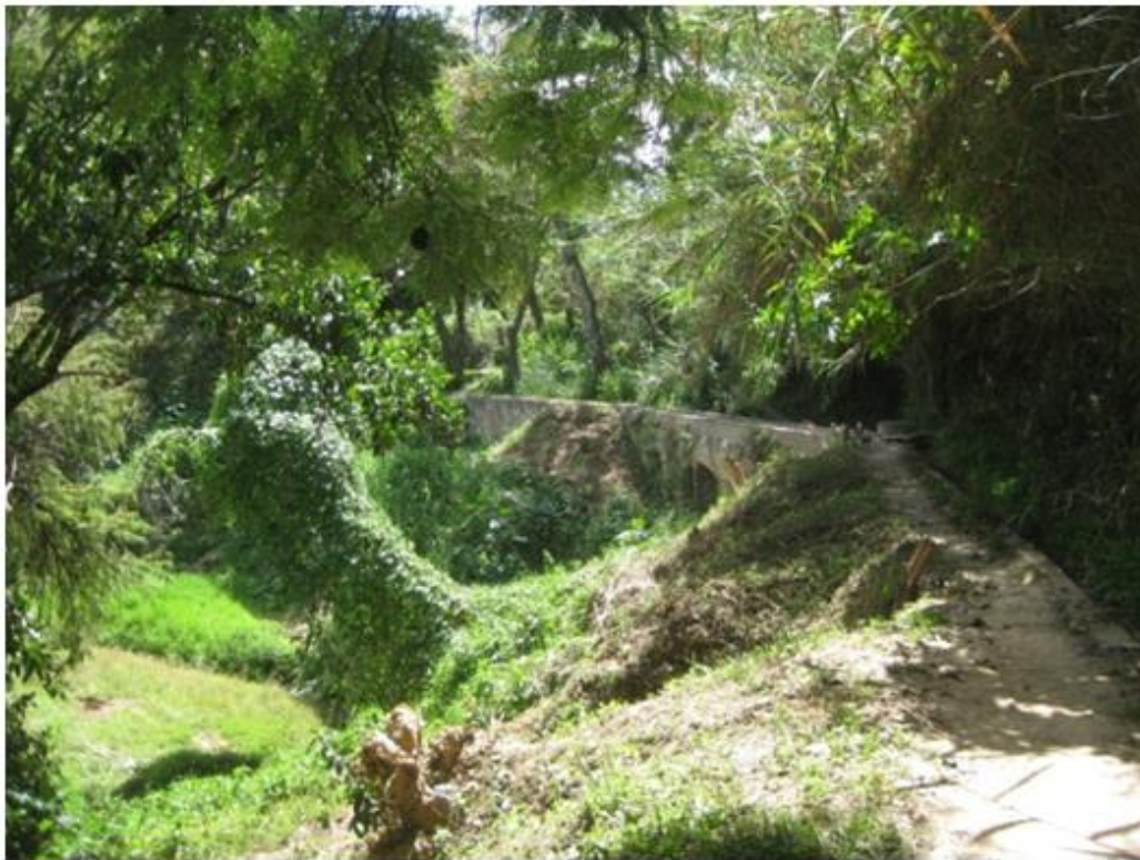
Imagen 7. Se puede apreciar la vegetación debido a la humedad.
