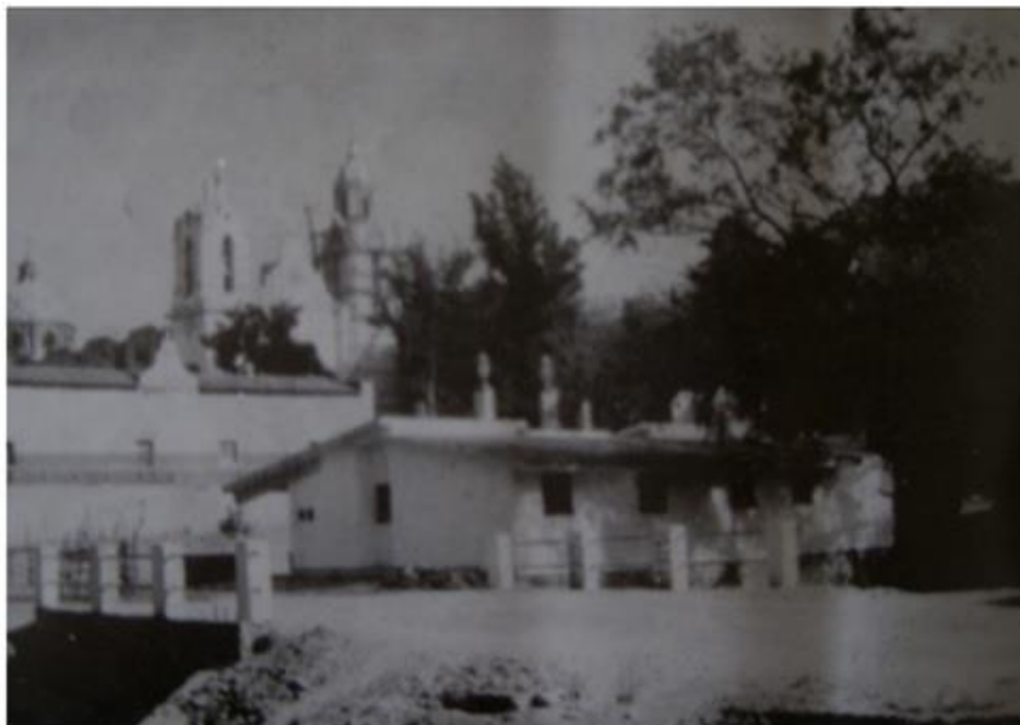
Imagen 16. El sismo del 24 de octubre de 1980 afecto gravemente la torre de la parroquia.
