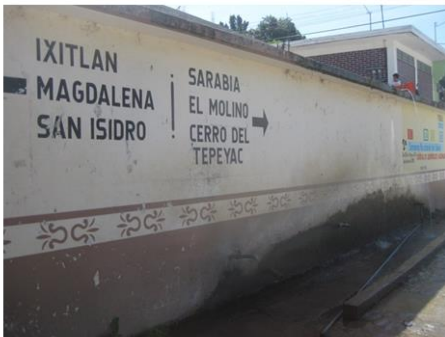
Imagen 57. Caja de agua, ubicada en la zona centro. Fuente: Foto del autor, 2013
