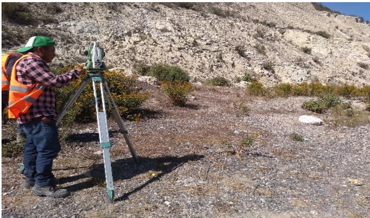
Figura 31.- Levantamiento topográfico a detalle en vialidad y zona afectada.
