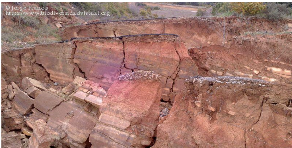
Figura 7.-Falla por deslizamiento de bloques.
