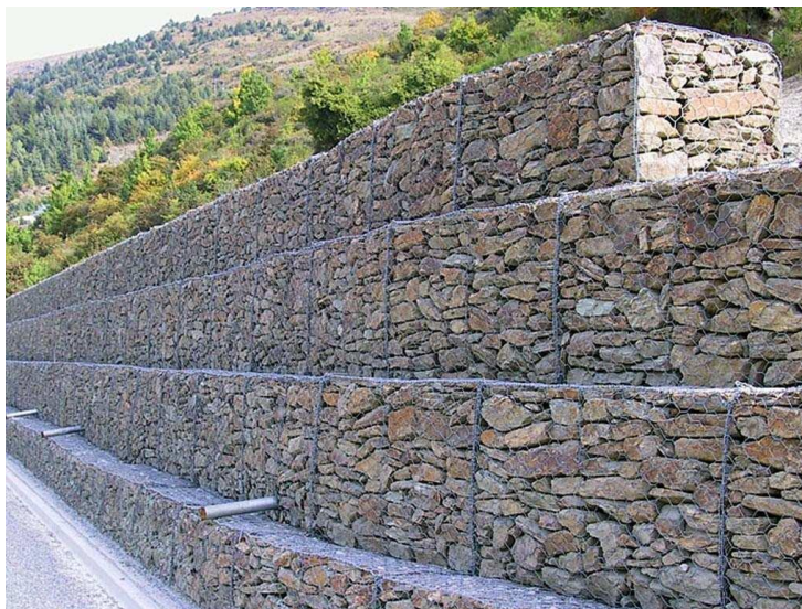
Figura 41.- Muro gabi3n para retenci3n de ca3dos.
