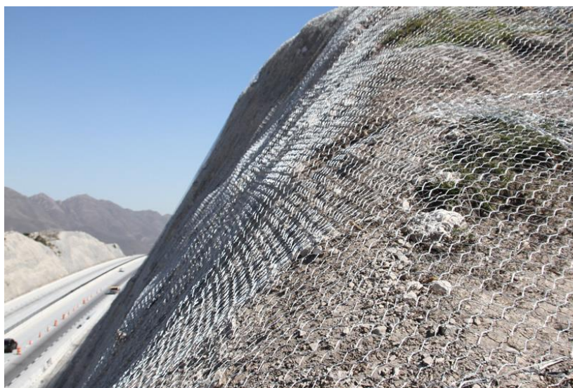
Figura 59.- Recubrimiento de talud con malla triple torción.
