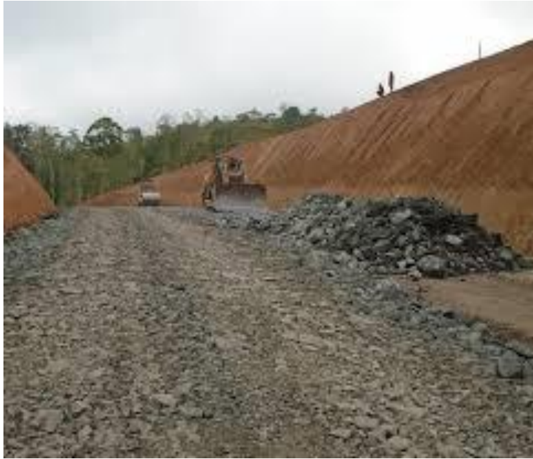
Figura 42.- Pedraplén en tramo inestable de arroyo de vialidad.
