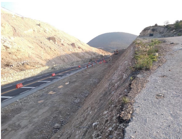
Figura 53.- Abatimiento y perfil terminado a nivel de rasante.
