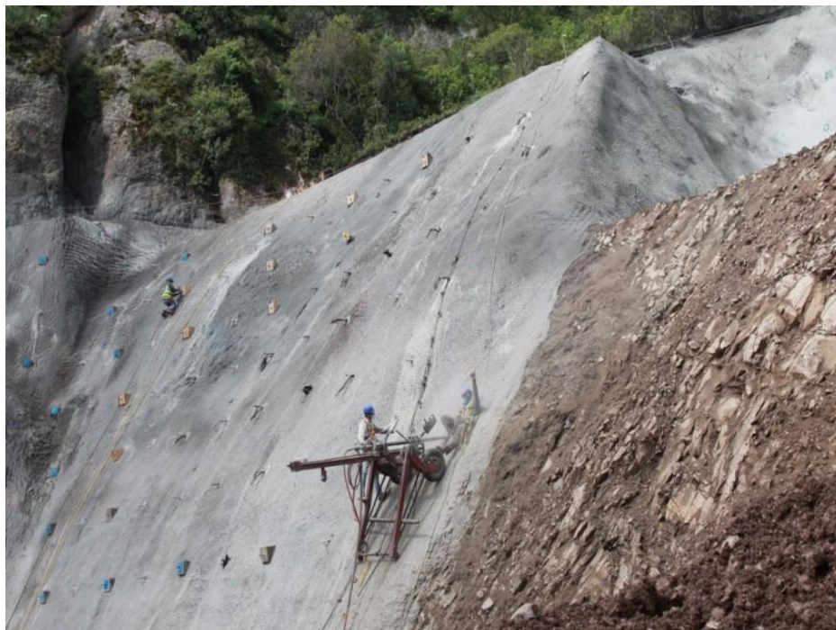
Figura 57.- Anclas de fricción en cara frontal de talud estabilizado.
