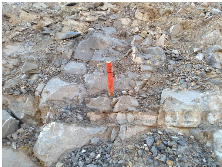
Figura 52.- Control topográfico de corte de talud II.
