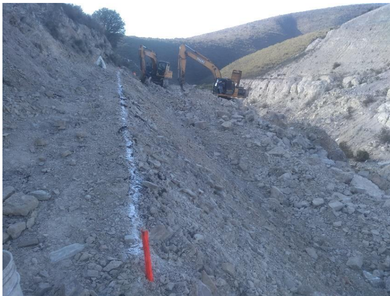
Figura 51.- Control topográfico de corte de talud I.
