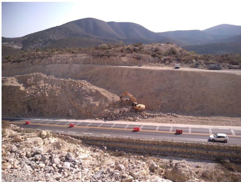
Figura 44.- Abatimiento de talud izquierdo II.
