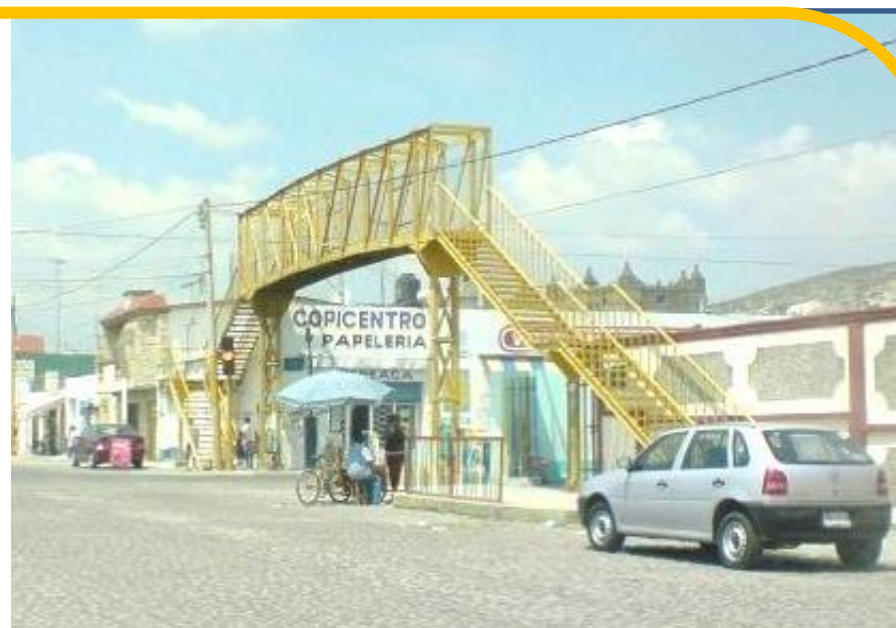
Puente Peatonal Miguel Negrete Ote.
