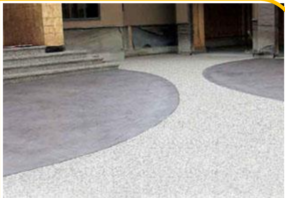
Imagen 68: Concreto estampado en piso
