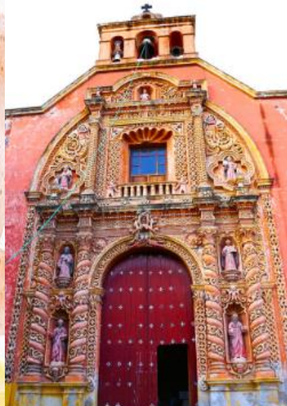
FIGURA 18 PORTADA DE LA TERCERA ORDEN DE SAN FRANCISCO (INH 2025) RECUPERADA DE: https://www.inah.gob.mx/boletines/8446-al-80-la-restauracion-de-la-capilla-de-la-tercera-orden-de-san-francisco-en-atlixco-puebla
