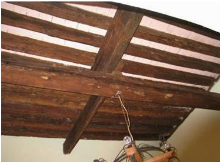
Foto no .37.- Vista interior de cubierta de viguería de casa ubicada en la 3 norte no 206.
