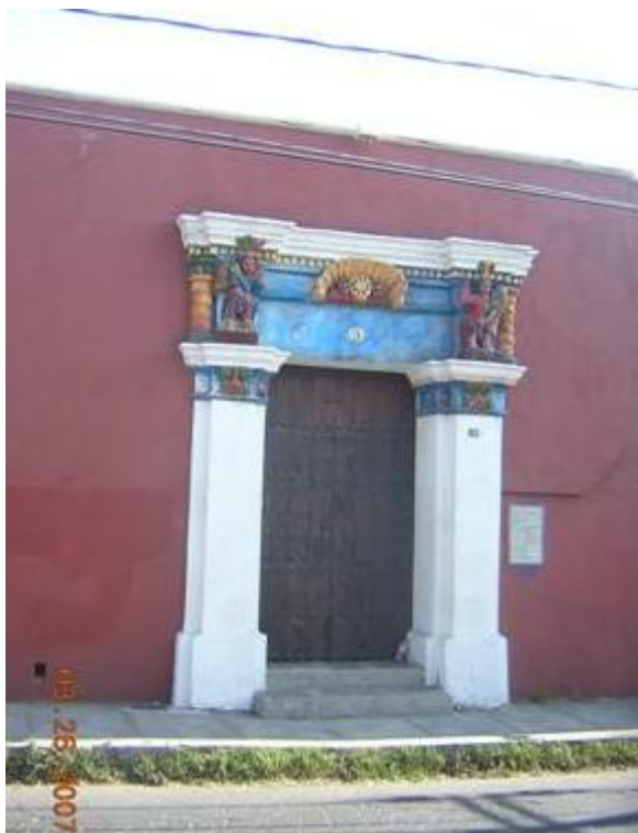
Foto no. 23.- Fotografía del acceso de la casa de la 10 poniente no 106.
