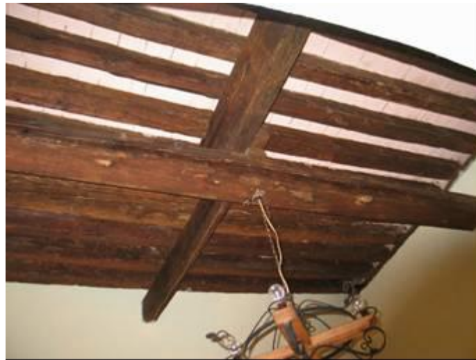
Foto no 6.-Detalles de cubierta de viguería , donde se observan las vigas de arrastre y las de apoyo Casa de la 3 norte no..
