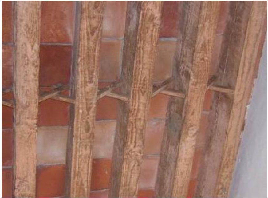
Foto no. 36.-Vista interior de cubierta de viguería. Casa 6 poniente no. 108.
