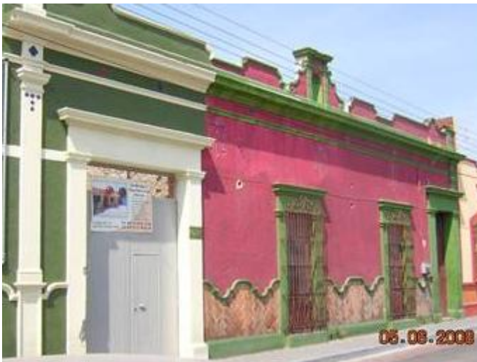
Foto no. 29.- Casa siglo XVIII, ubicada en calle 2 oriente no 403.
