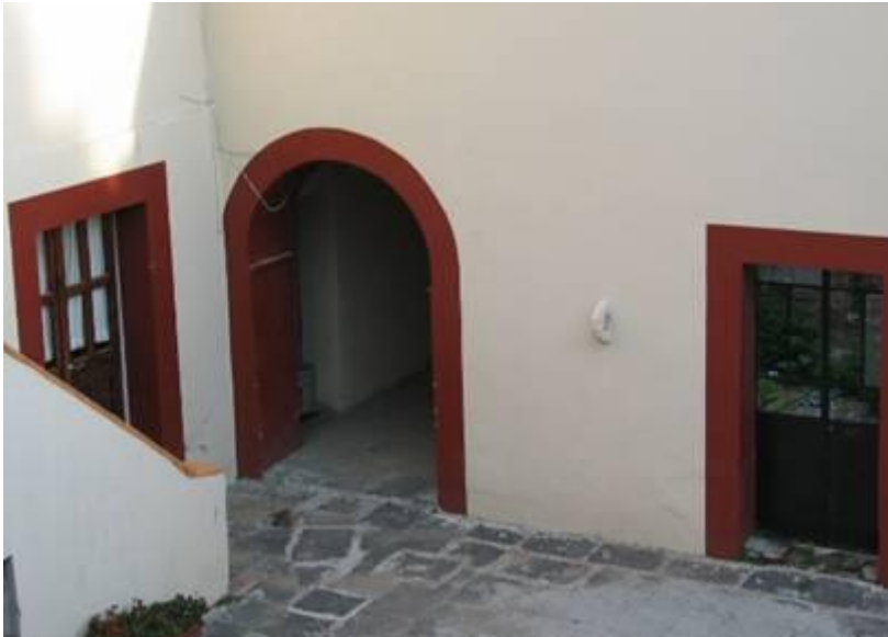
Foto no. 38.- Detalle de patio de casa del siglo XVIII, de cantería, en el inmueble
