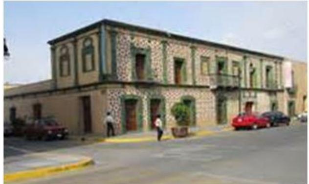
Caracterización de la arquitectura.
