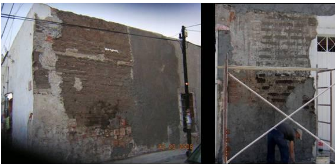
Foto no. 16.- Muro de tabique de adobe de la casa de la 6 oriente esquina con 5 de mayo no 1, durante intervención.
