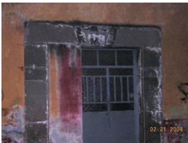
Foto no. 9.-Detalle de Enmarcamiento, jambas y platabanda de cantería. Casa 3 norte no 605.
