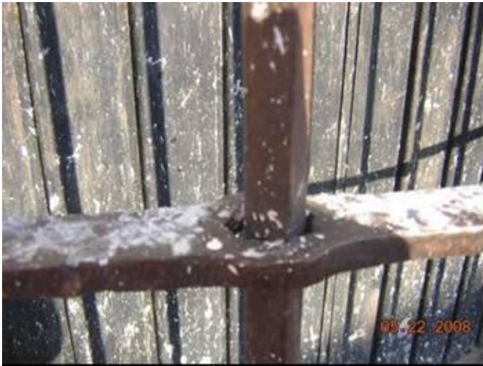
Foto no. 19.- Imagen de la herrería de forja, que se encuentra actualmente en las fachadas exteriores del inmueble de la 6 oriente no 1.
