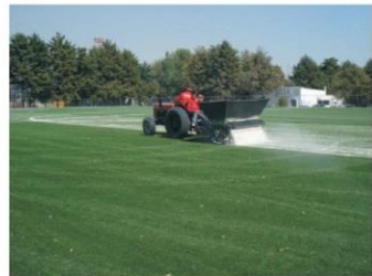
9.-Tendido de arena sílica
