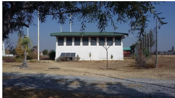
Figura 1.23: Imagen tomada dentro del parque Bicentenario 18 de Noviembre, donde se pueden apreciar la forma de los edificios administrativos, con la losa inclinada para captar el agua pluvial, además de contar con paneles solares con una altura de 1.20 metros a nivel de suelo.
