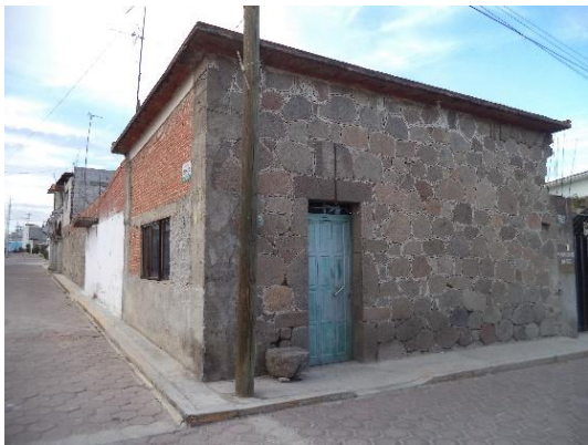
Imagen 3.4. Casa con combinación de fachada vieja de piedra con nueva de tabique. Fuente. Archivo fotográfico RGB y MCDJG.
