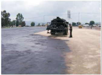
5.-Riego de emulsión
