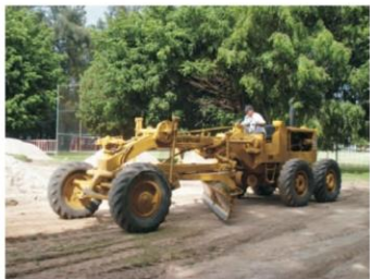
1.- Despalme del terreno natural
