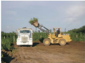
2.- Carga y retro de material de despalme
