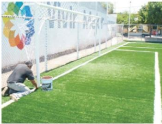
11.-Colocación de Porterías
