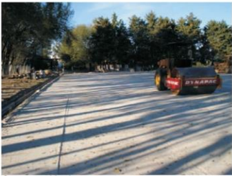
4.-Compactación de terreno
