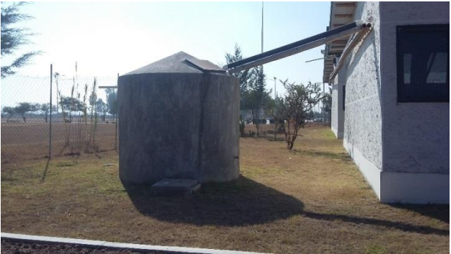
Figura 1.26: Imagen tomada dentro del parque Bicentenario 18 de Noviembre, donde se pueden apreciar la forma del tinaco de ferrocemento, además de la tubería de PVC de 4 pulgadas para la captación de agua pluvial.
