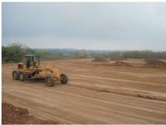
3.- Extendido de material
