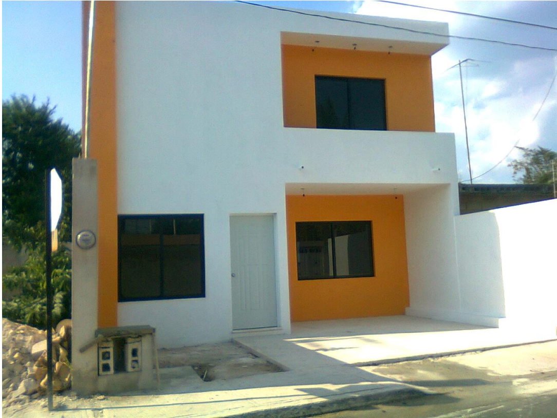
FACHADA PRINCIPAL DE LA VIVIENDA; CON VISTA SOBRE LA CALLE 13
