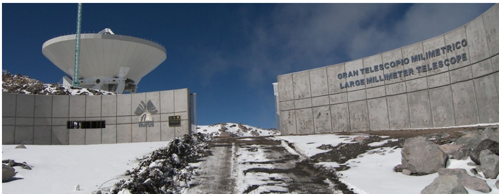
Impresionantes imágenes de las instalaciones externas del Gran Telescopio Milimétrico en la cima de la Sierra la Negra.
