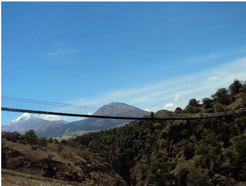
Vista general del puente colgante en la barranca de San Francisco Cuautlancingo (El Barrio), con el bello paisaje del Volcán Cuitlaltépetl y las formaciones de lomeríos.
