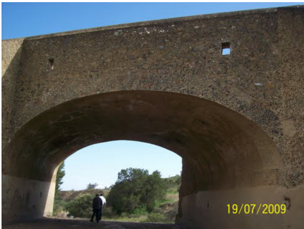
A 800 metros al norte de la Ermita, se localiza el Puente Revolucionario de la Ermita. Es una estructura civil hecha a base de piedra volcánica que libra el claro de un río intermitente de la zona, y se puede observar que se encuentra en buenas condiciones tanto estructurales como de materiales.
