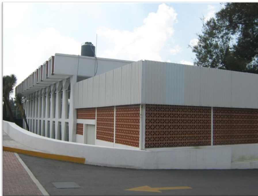
Figura 4.20 Ubicación del tanque de agua de servicio o agua cruda.
