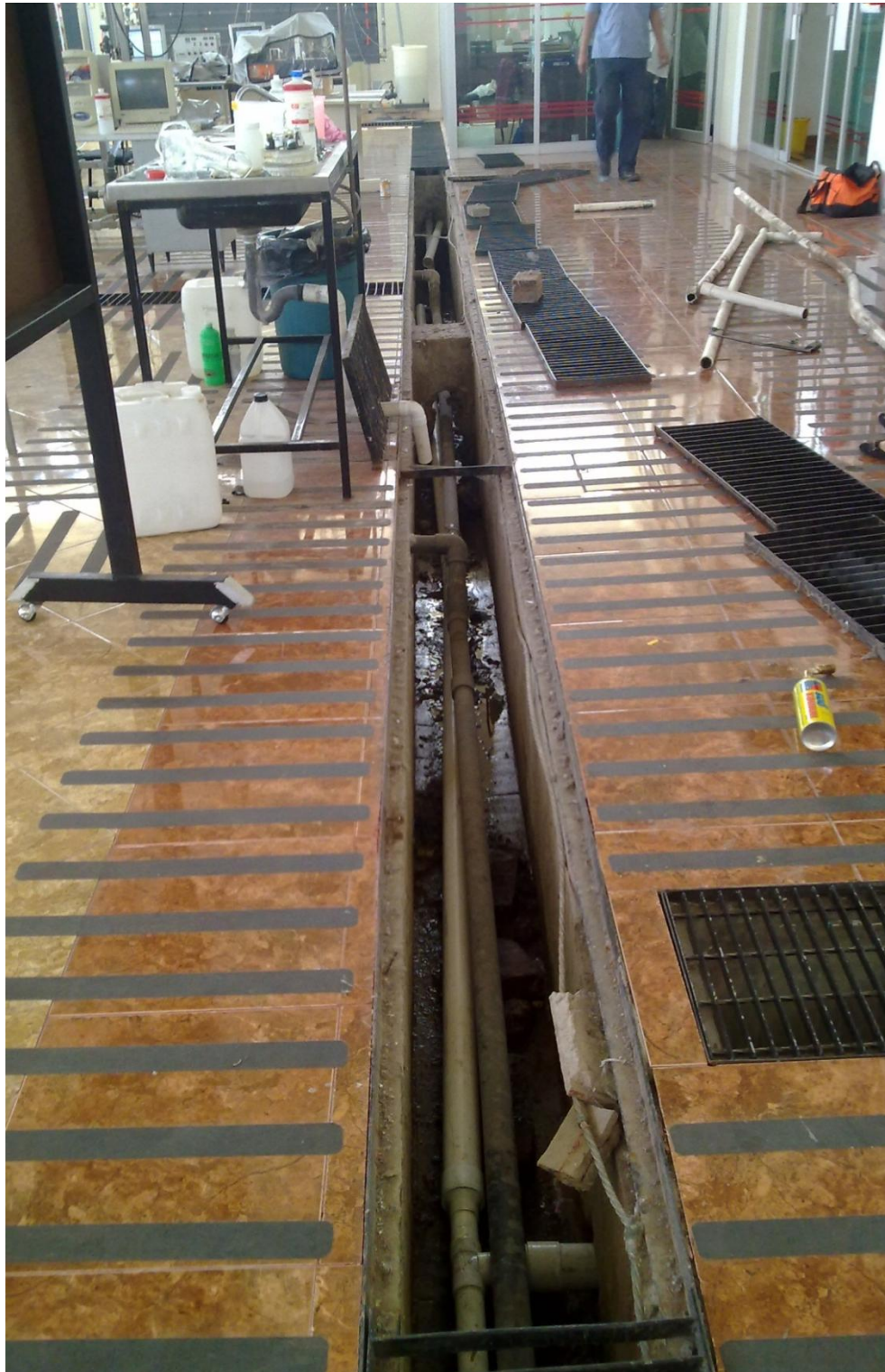
Figura 4.36.- Vista del canal de drenaje interno que se extiende debajo de las rejillas de servicio.
