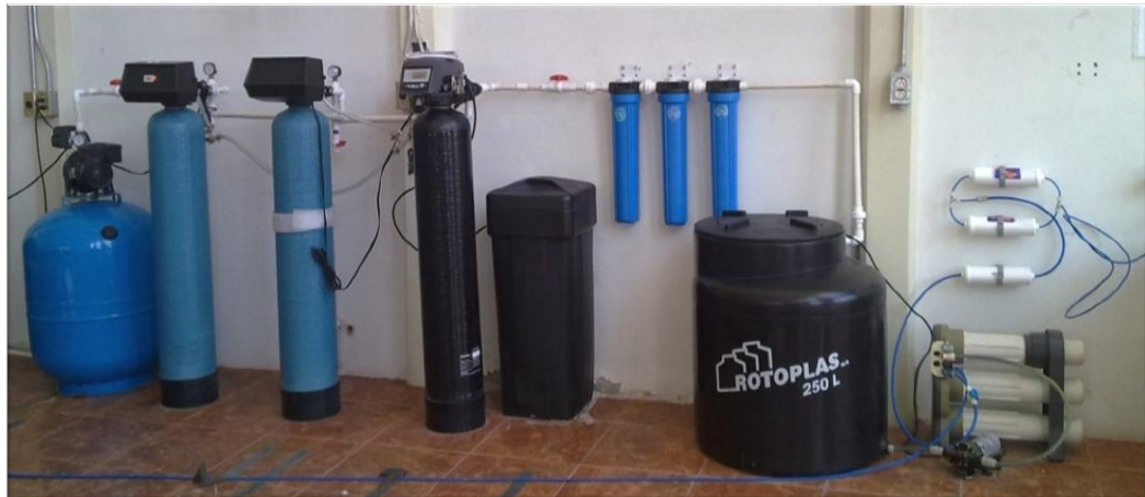
Figura 5. 18 Sistema de desionización de agua del LOU. Vista frontal.
