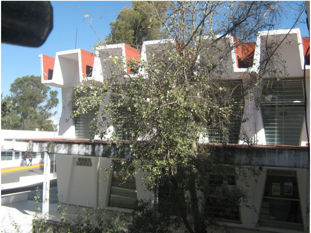
Figura 4.6 Se muestra la fachada posterior o pasillo de acceso.
