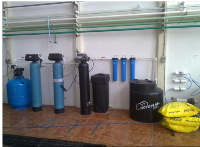
Figura 1.5 Servicio de desionización y filtración el cual brinda agua desionizada a la demás facultades, en laboratorios que la requieran
