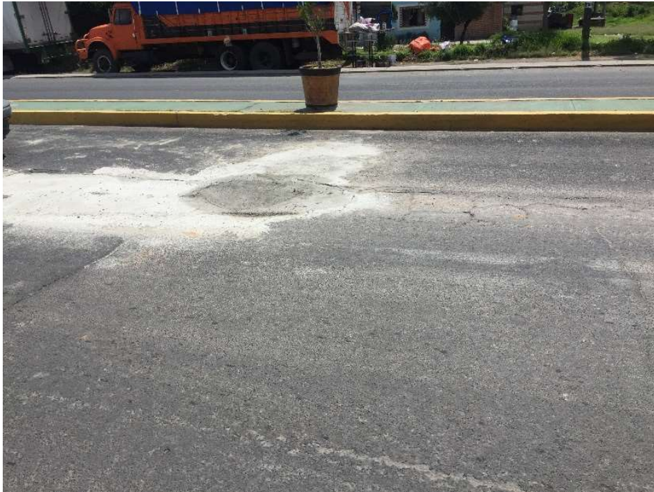
Ilustración 20: Bache reparado moderado, Carretera Federal México Puebla km 95
