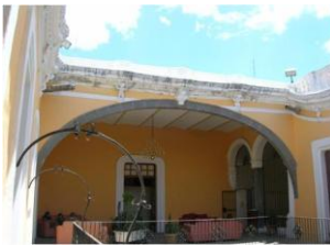
ARCO DE 5 PUNTOS APOYADO EN MUROS
