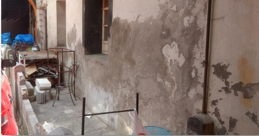
Foto 19.- Interior de la casa, primer patio.
