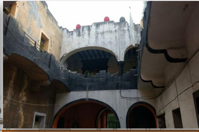
Foto 2.-Interior de la casona, primer patio, condición actual.
