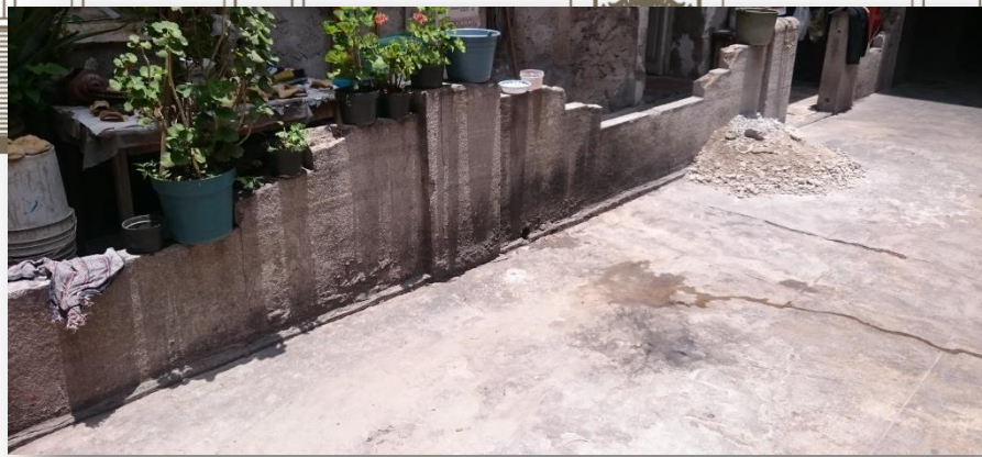
Foto 23 - Interior de la casa, primer patio.
