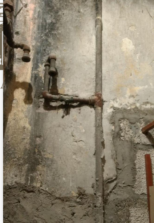
Foto 5.- Instalación hidráulica, WC, planta alta.
