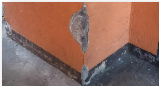
Foto 10.- Interior de la casa, acceso principal.
