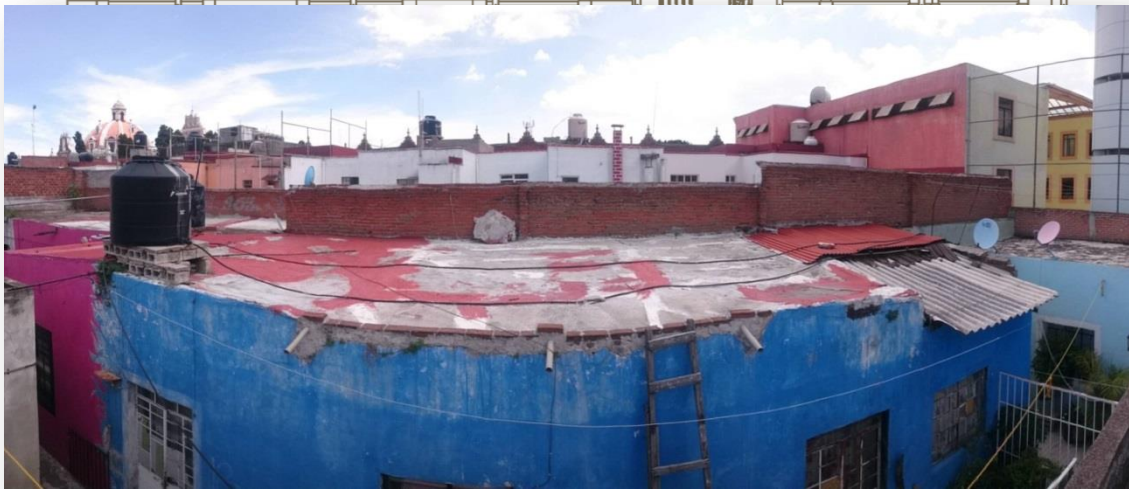
Foto 26.- Azotea, segundo patio.
