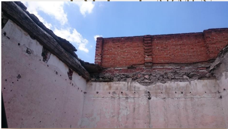
Foto 11.- Interior de habitaciones, planta alta.
