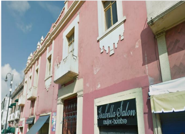
Foto 1.-Fachada de la casona, calle 16 de septiembre.
