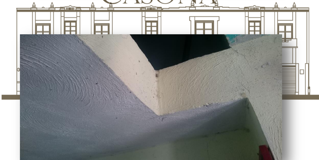
Foto 16.- Interior de habitaciones, planta baja.
