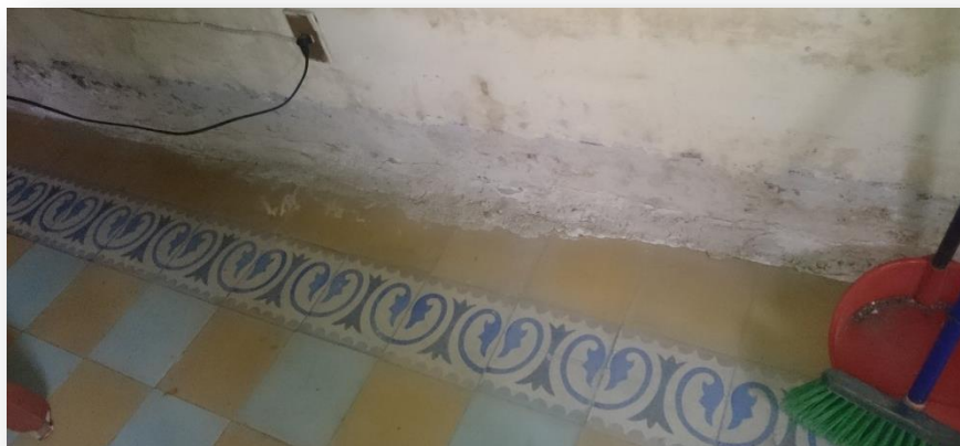
Foto 24.- Interior de habitaciones, planta alta.
