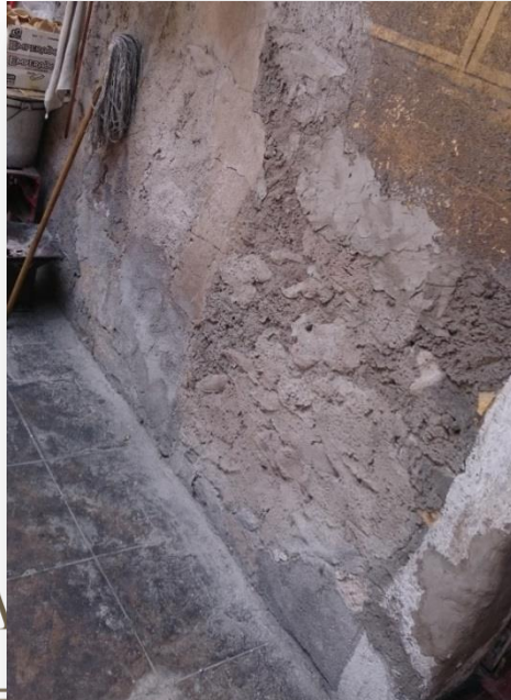
Foto 22.- Interior de la casa, primer patio.
