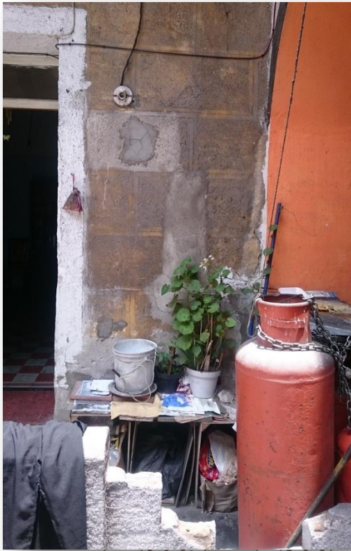
Foto 6.- Instalación de gas, interior de la casa, primer patio.
