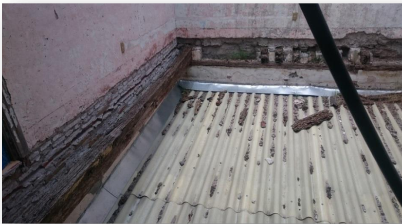
Foto 13.- Interior de habitaciones, planta alta.
