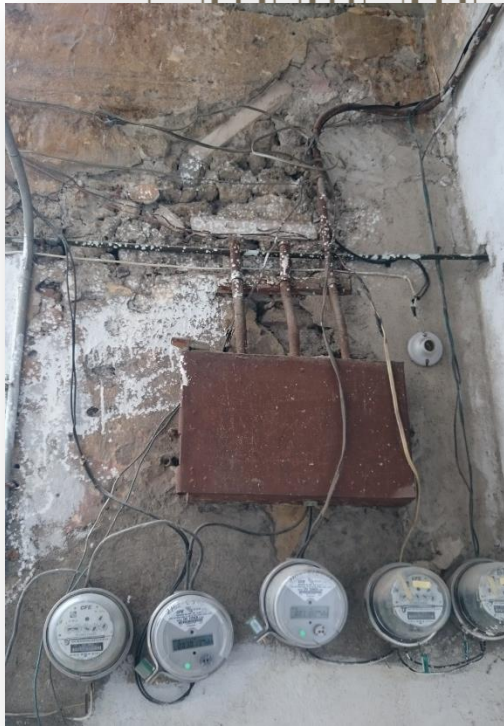
Foto 4.- Instalación eléctrica, interior de la casa, segundo patio.
