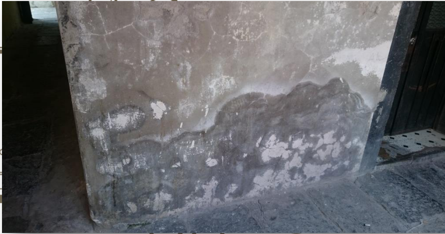
Foto 20.- Interior de la casa, primer patio.
