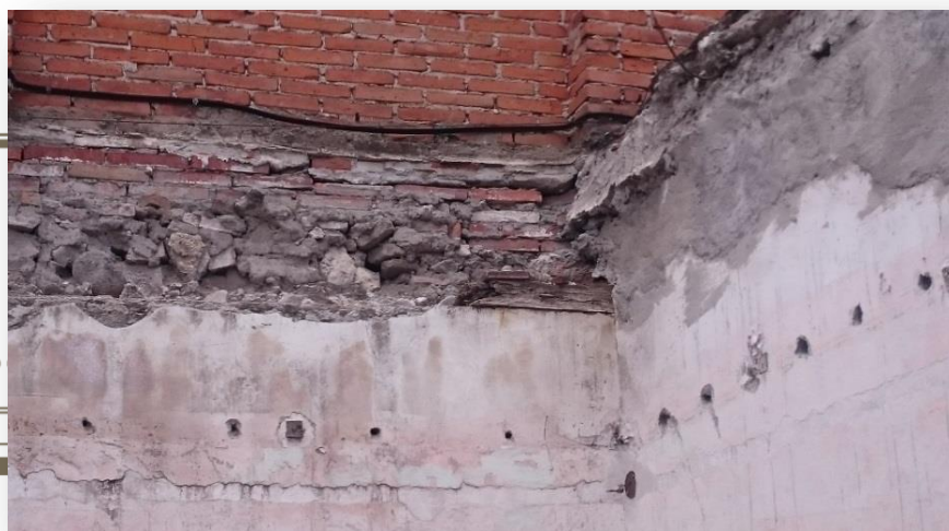
Foto 12.- Interior de habitaciones, planta alta.
