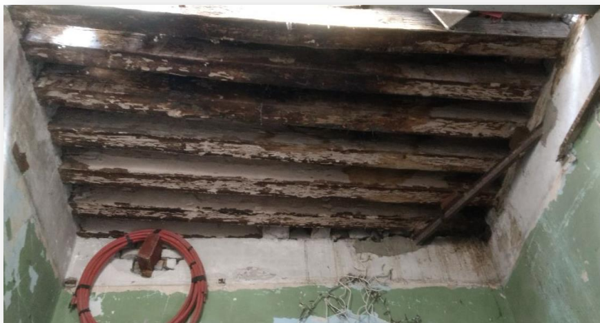
Foto 17.- Habitaciones a WC, primero patio.
