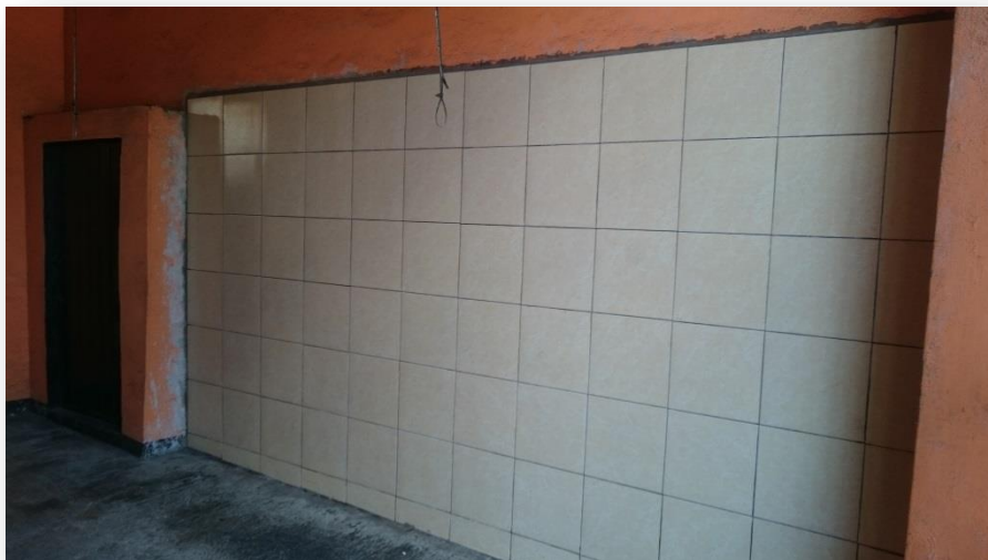
Foto 21.- Interior de la casa, acceso principal.
