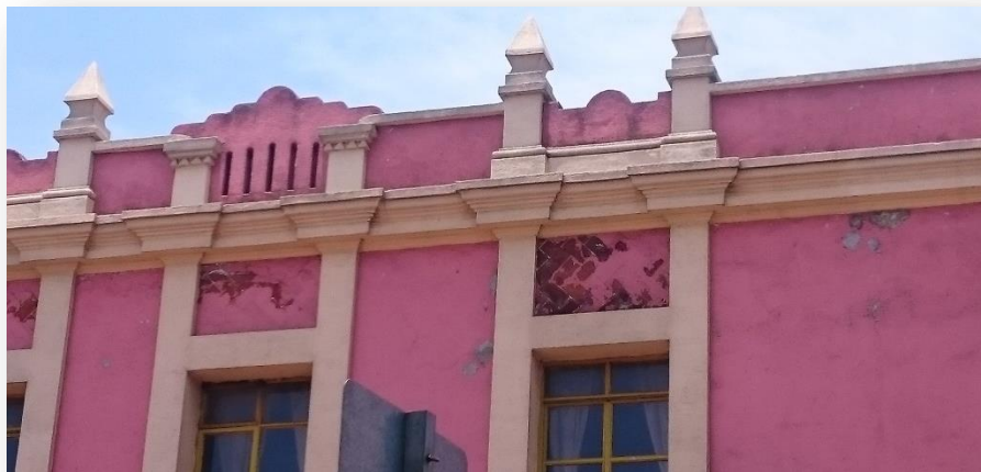
Foto 18.-Fachada de la casona, calle 16 de septiembre.
