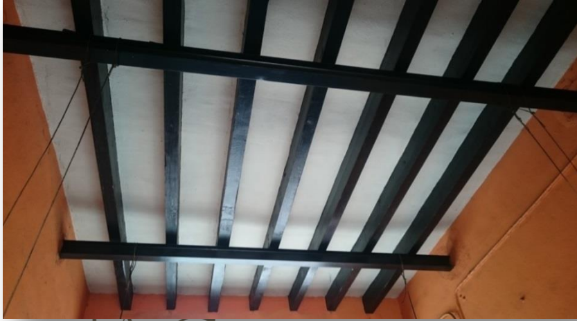
Foto 15.- Interior de la casa, acceso principal.
