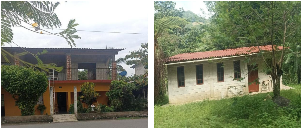
Figura. 4 Viviendas localizadas en el municipio de Ayotoxco de Guerrero y Jonotla respectivamente, construidas con materiales no naturales.
