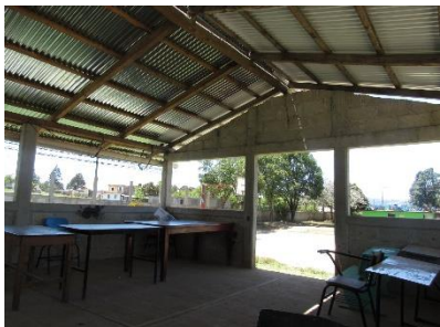
Fotografía 67 interior comedor Fuente: elaboración propia
