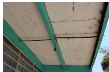
Fotografía 4. losa hecha con el sistema CAPFCE. Elaboración propia.
