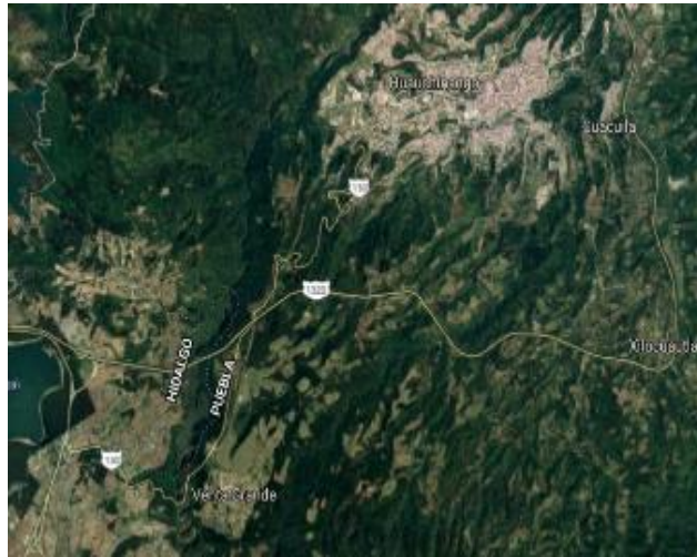
Fotografía37: carretera MEX 132 D vía satelital
