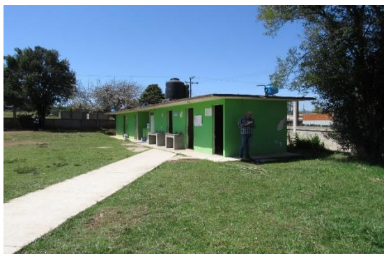
Fotografía 72 fachada este sanitario Fuente: elaboración propia
