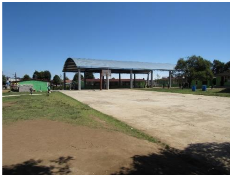
Fotografía 76 cancha y patio techado vista sur - norte Fuente: elaboración propia
