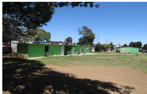
Fotografía 73 fachada este sanitario Fuente: elaboración propia
