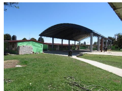
Fotografía 61 vista sur de patio techado y cancha
