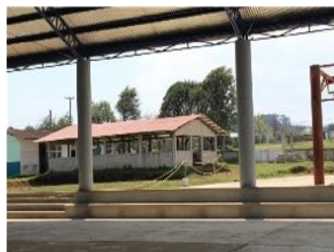
Fotografía 3. Comedor y cancha de la primaria. Elaboración propia.
