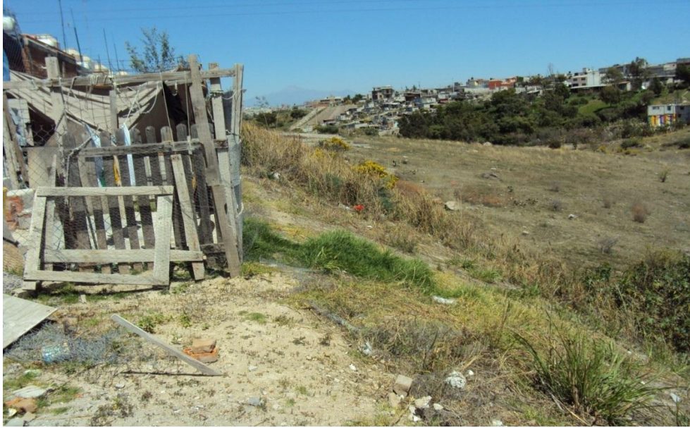
Fotografía 1. Barranca la luz, atrás de las casas afectadas, obsérvese enfrente los asentamientos irregulares que también viven en situación de riesgo. (Zayarzabal, 4 de julio de 2012).
