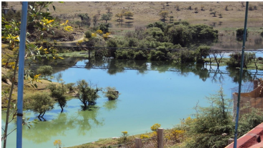
Fotografía 3. Canal de aguas de drenaje en el fondo de la barranca (Zayarzabal, 4/ 07/ 2012).
