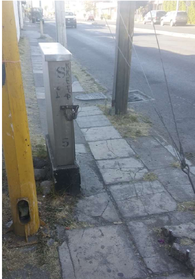
Imagen 27. Existencia de postes de teléfono y retenidas causan que disminuya el espacio para a circulación peatonal. Ortega, 2017
