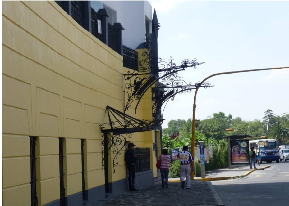
Foto 3.- Bulevar H. 5 de Mayo, se puede observar el contraste que genera el edificio, con la tipología existente.
