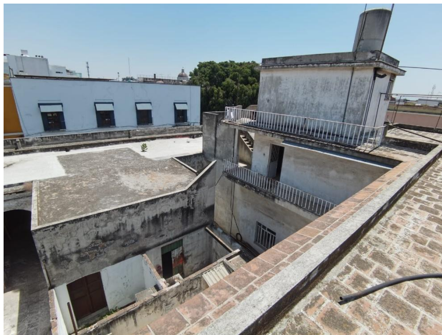
Figura 9. Fotografía del interior de la casa C. 5 Sur 507 Centro Histórico de Puebla (21 abril 2022).
