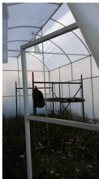
Figura 5.4: Imagen del interior del invernadero.
