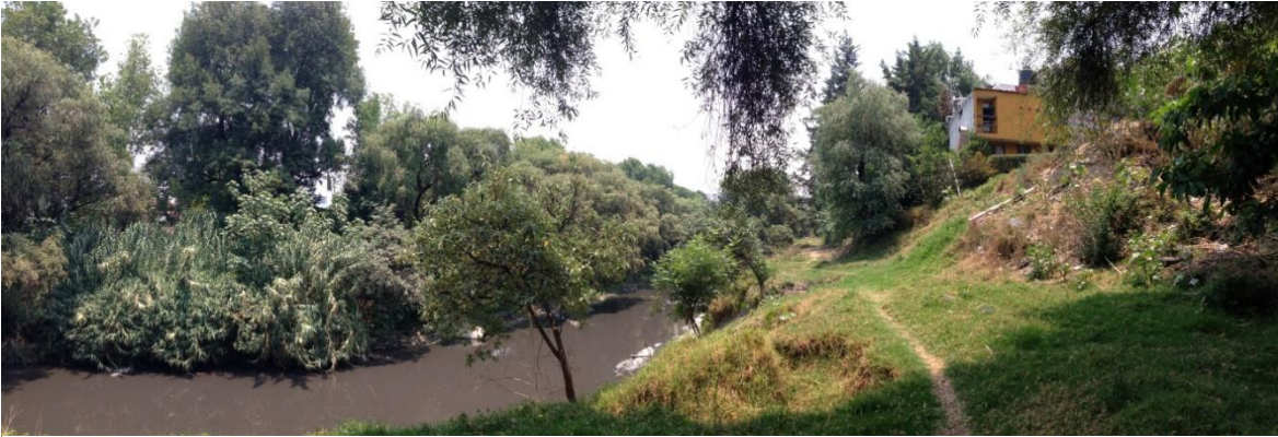
Ilustración 12. Foto de la brecha que se encuentra entre el río y las casas de los habitantes de San Miguel la Rosa, Ana Karen Acua Hdz. (04/2013)
