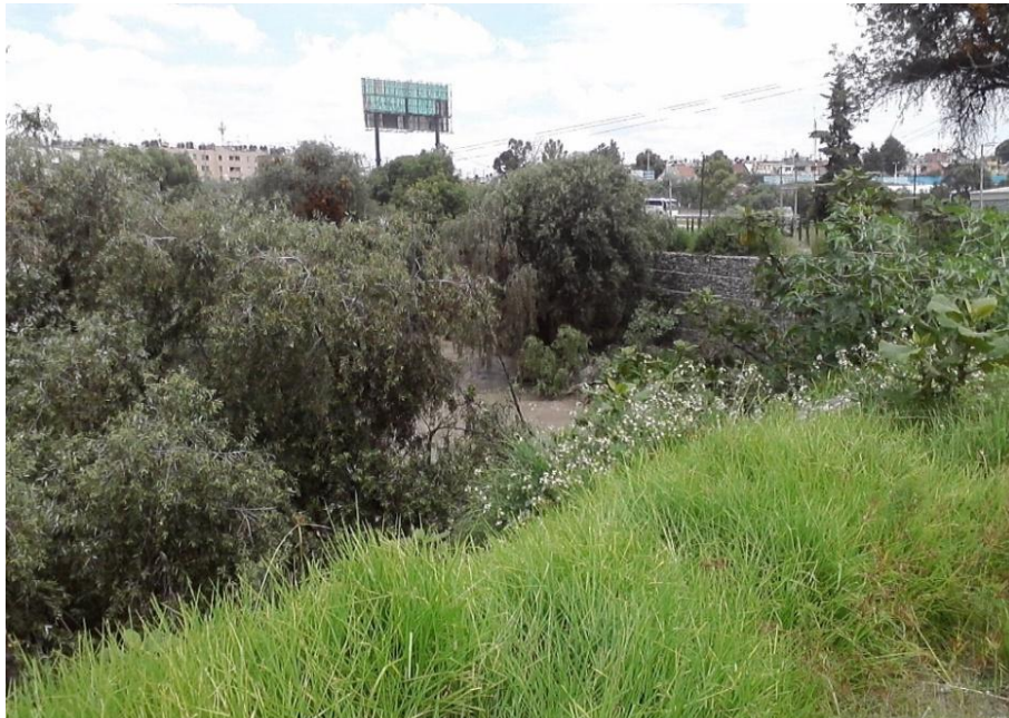
Ilustración 5. Vista de los muros de gavión implementados como obra de emergencia. Ana Karen Acua Hdz. (08/2014).
