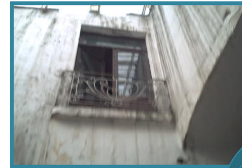
FOTO NO. 16: BALCON PATIO DE SERVICIO BLAS, MORA, ORTIZ JULIO 2009
