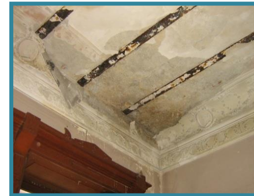
FOTO NO. 62: DETALLE DE LOSA BLAS, MORA, ORTIZ JULIO 2009
