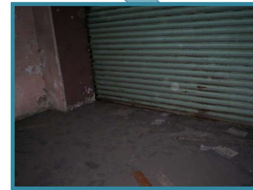
FOTO NO. 68: ANCHO DE MURO BLAS, MORA, ORTIZ JULIO 2009
