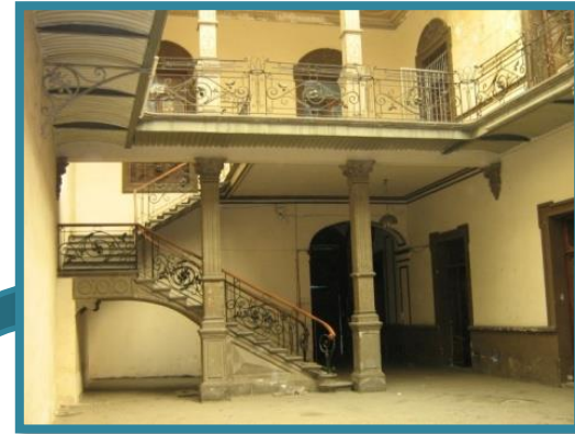
FOTO NO. 6: ESCALERA PRINCIPAL BLAS, MORA, ORTIZ JULIO 2009
