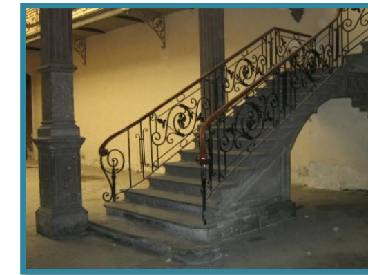
FOTO NO. 4: ESCALERA PRINCIPAL BLAS, MORA, ORTIZ JULIO 2009
