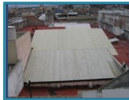
FOTO NO. 15: VISTA DE LA CUBIERTA DEL PATIO PRINCIPAL BLAS, MORA, ORTIZ JULIO 2009
