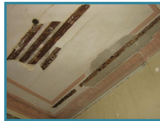
FOTO NO. 60: DETALLE DE LOSA BLAS, MORA, ORTIZ JULIO 2009
