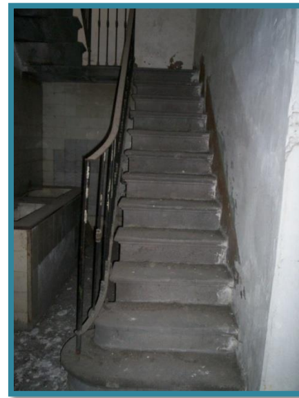
FOTO NO. 35: ESCALERA DE SERVICIO BLAS, MORA, ORTIZ JULIO 2009
