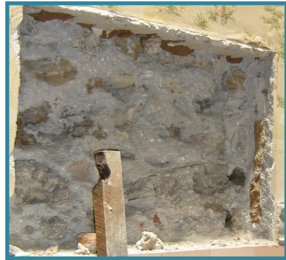
FOTO NO. 54: MURO EN ½ BAÑO BLAS, MORA, ORTIZ JULIO 2009
