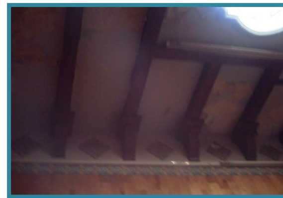
FOTO NO. 61: DETALLE DE LOSA BLAS, MORA, ORTIZ JULIO 2009
