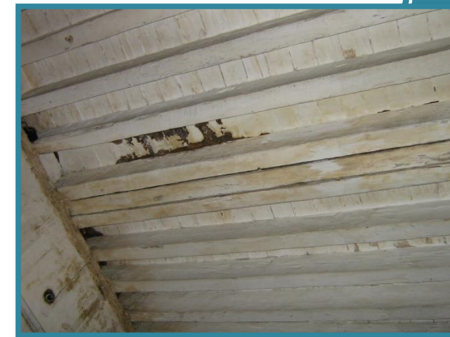
FOTO NO. 55: LOSA DE VIGUERIA BLAS, MORA, ORTIZ JULIO 2009
