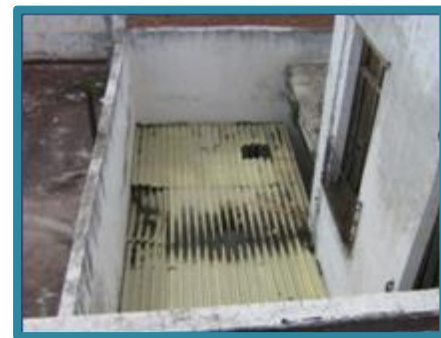
FOTO NO. 14: VISTA DE LA CUBIERTA DEL PATIO SERVICIO BLAS, MORA, ORTIZ JULIO 2009
