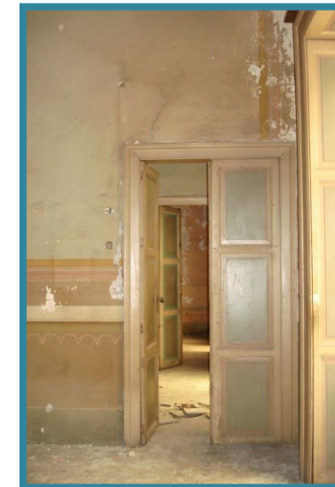
FOTO NO. 45: ACCESO A SEGUNDO NIVEL BLAS, MORA, ORTIZ JULIO 2009
