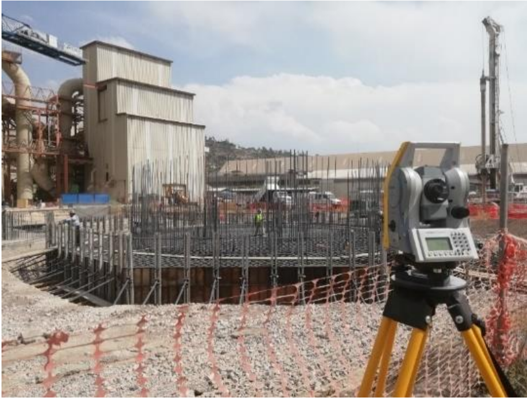
Figura 3.6.18 Segunda fase de cimentación
