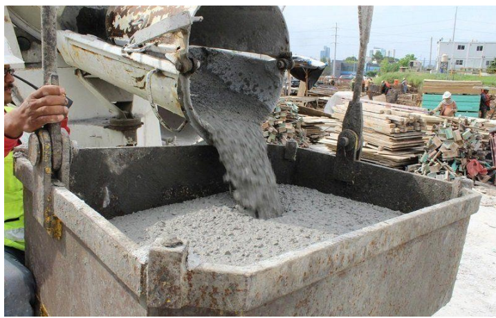
Figura 2.9.2 Vaciado de concreto premezclado
