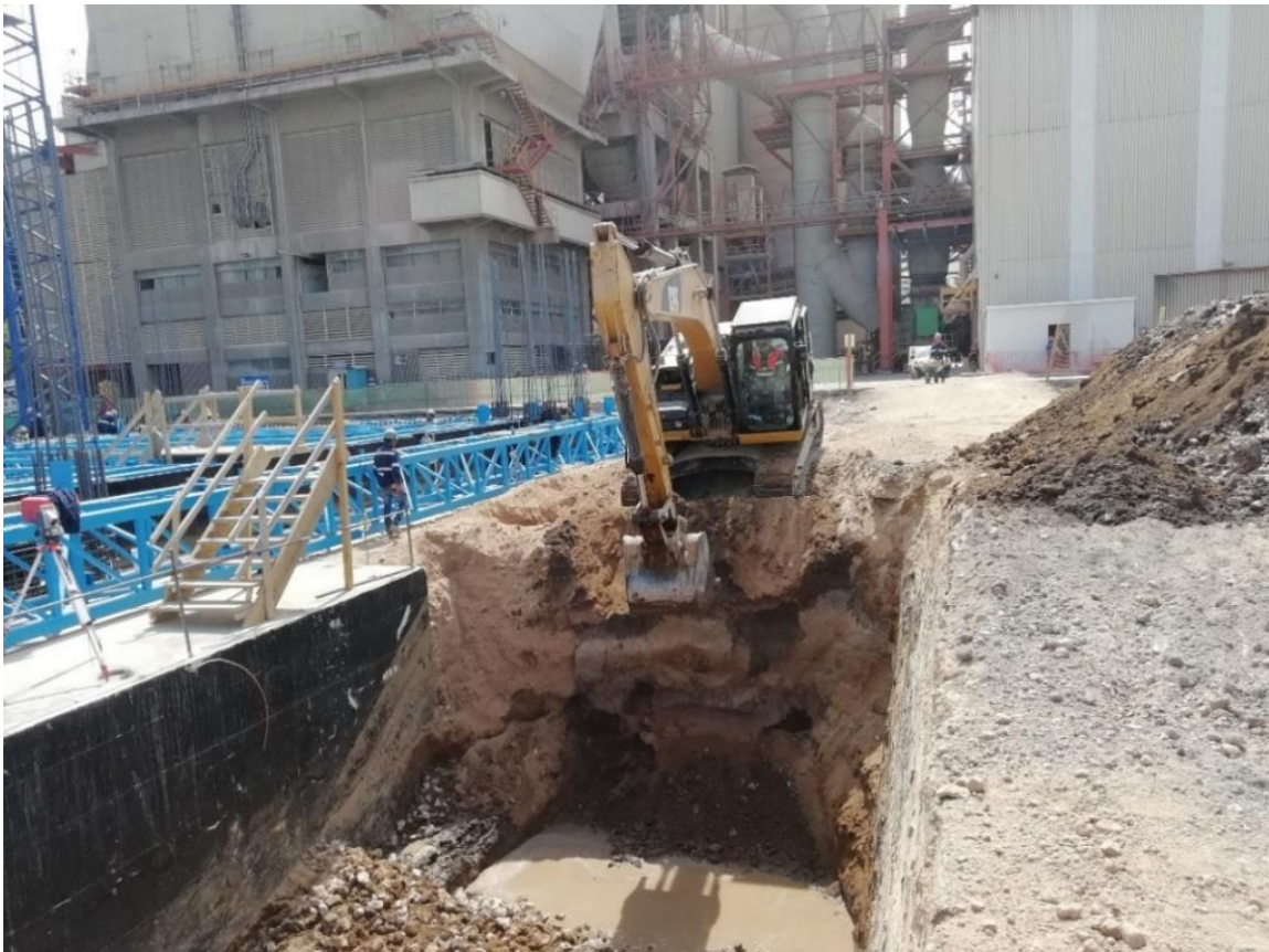
Figura 3.6.15 Revisión de nivel y alineamiento en excavación
