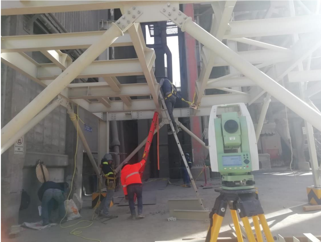
Figura 3.2.4 Verificación levantamiento en acero
