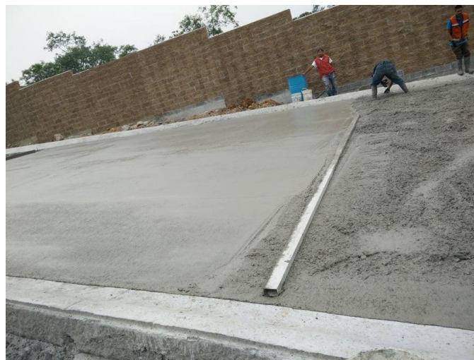
Figura 2.9.1 Tendido de concreto para pavimento
