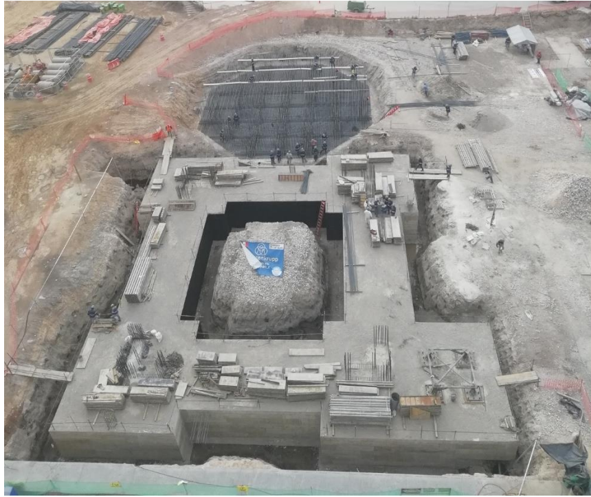
Figura 3.6.12 Cimentación de torre pre calentadora
