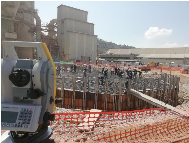
Figura 3.6.17 Control de cimbra para cimentación
