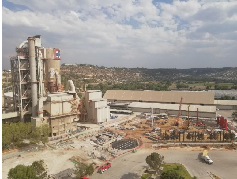
Figura 3.6.11 Panorámica de ampliación torre
