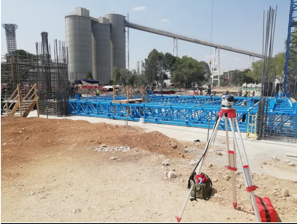
Figura 3.6.19 Control vertical de cuerpos cimbra
