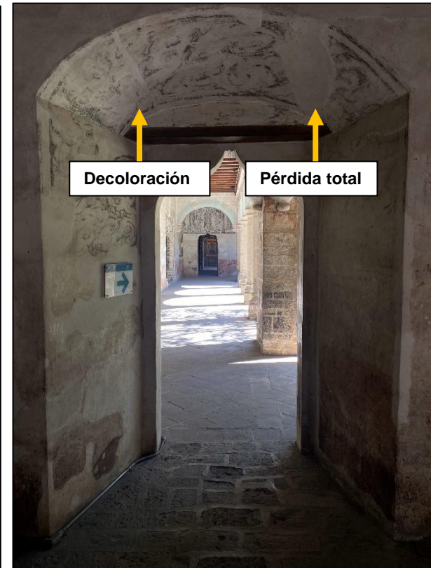
360 acceso al Claustro del convento
