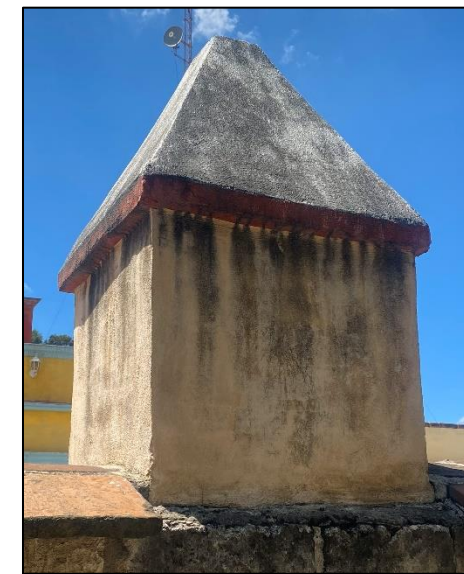
127 almena de la barda perimetral.
