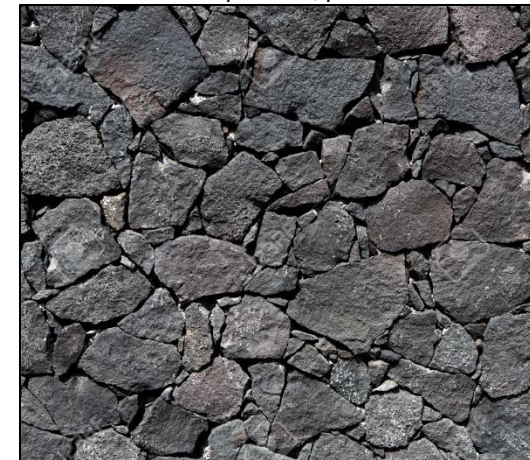
89 muro de mampostería, piedra volcánica.
